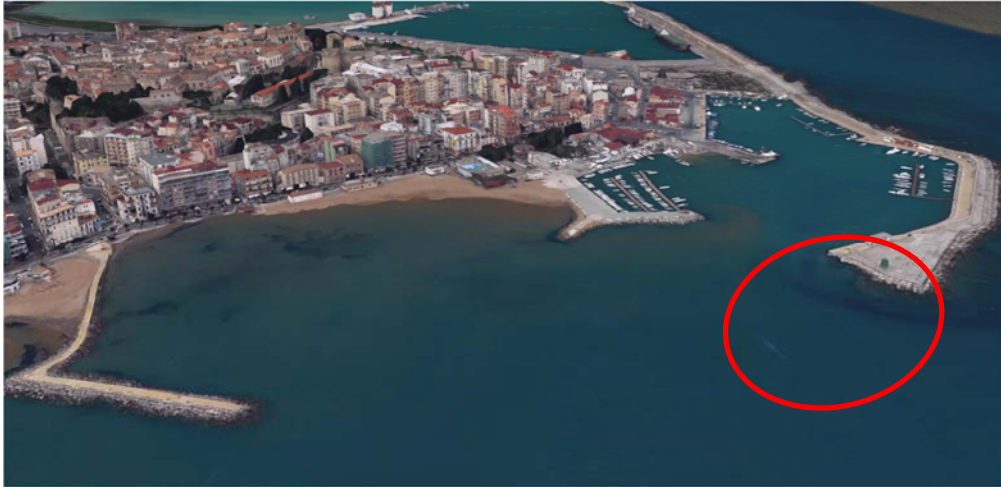
Figura 6.2 - Localizzazione area di intervento (cerchiata in rosso)
