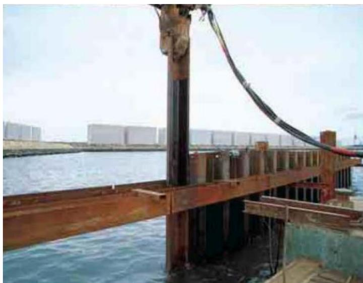
Figura 2.20 – Installazione del palancolato tramite vibroinfissore.
