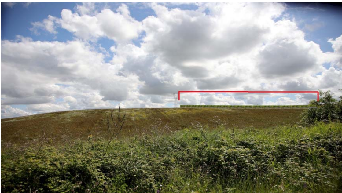
Stato di progetto: impianto non nettamente distinguibile.
