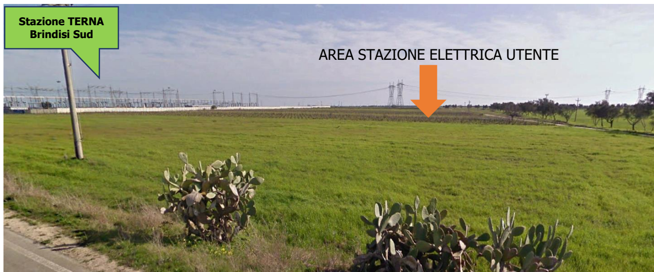
Figura 3-2: Foto dell'area di futura Stazione elettrica utente
