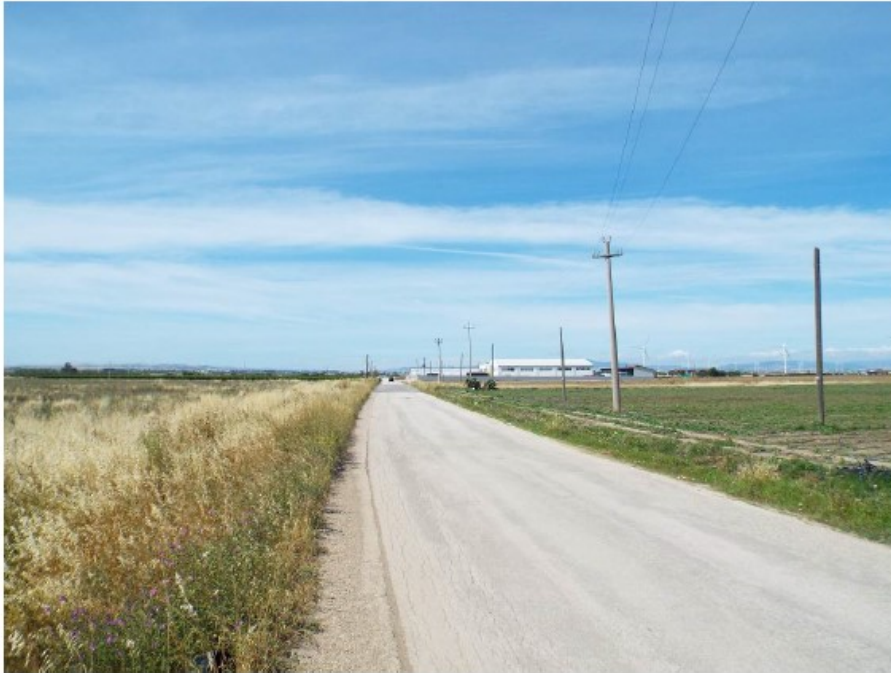
Figura 32: Vista della SP79 interessata dal passaggio del cavidotto interno dall'aerogeneratore WTG10 in direzione di Ortona
