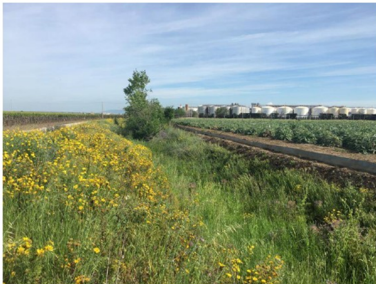
Figura 34: Vista del Canale Ponticello in prossimità dell'attraversamento del cavidotto esterno - Sezione a Valle
