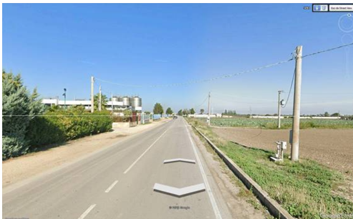
Figura 36: Vista da Tratturello Stornarella-Carapelle, da Orta Nova verso Carapelle in corrispondenza della WTG10
