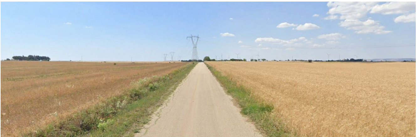
Figura 7-1: Strada Statale SP193 in prossimità dell'impianto
