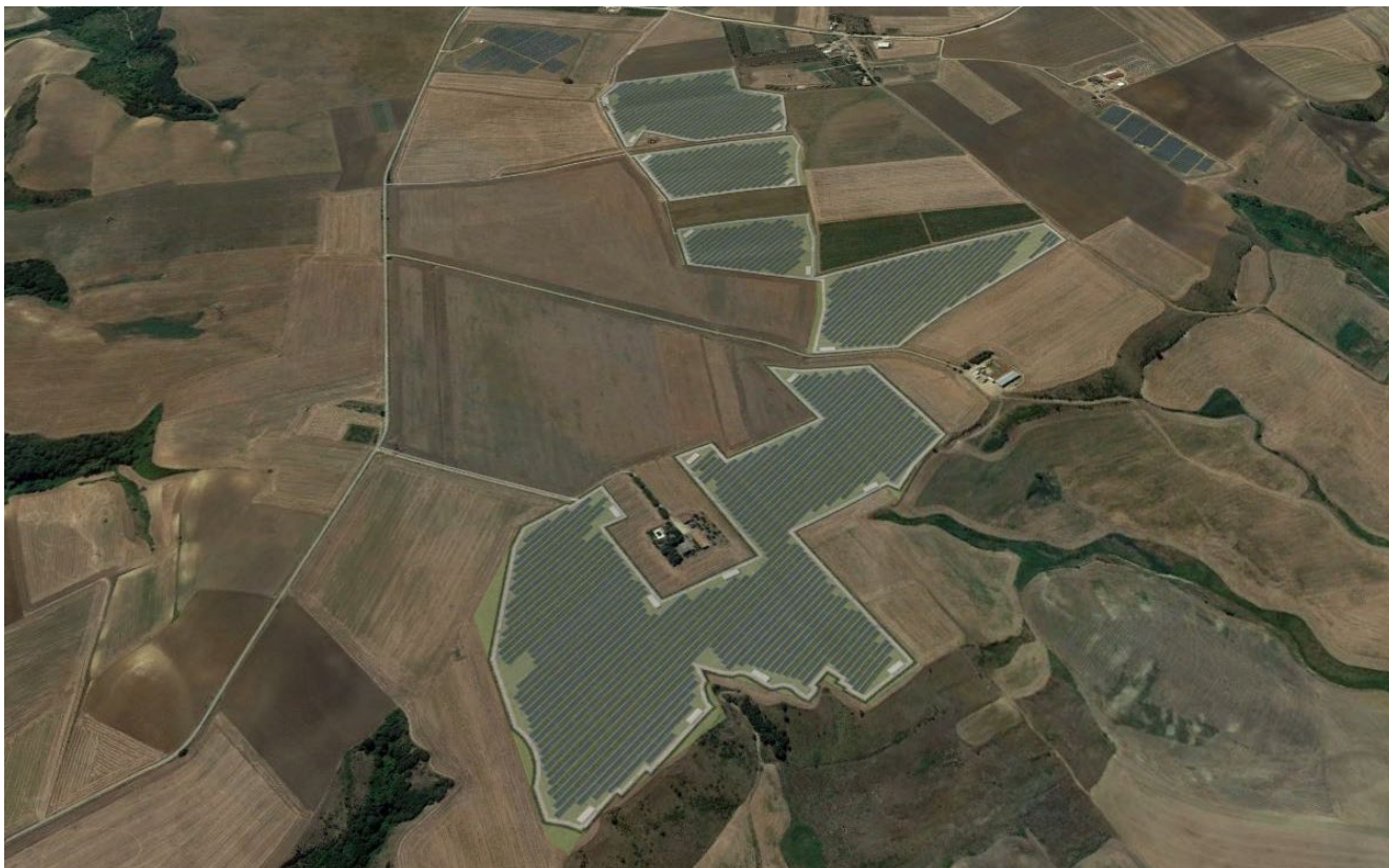
Vista A – Lato Nord-Ovest
