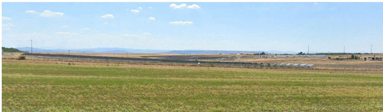
Figura 15-10: Impianti fotovoltaici già realizzati a sud-est dell'area di intervento
