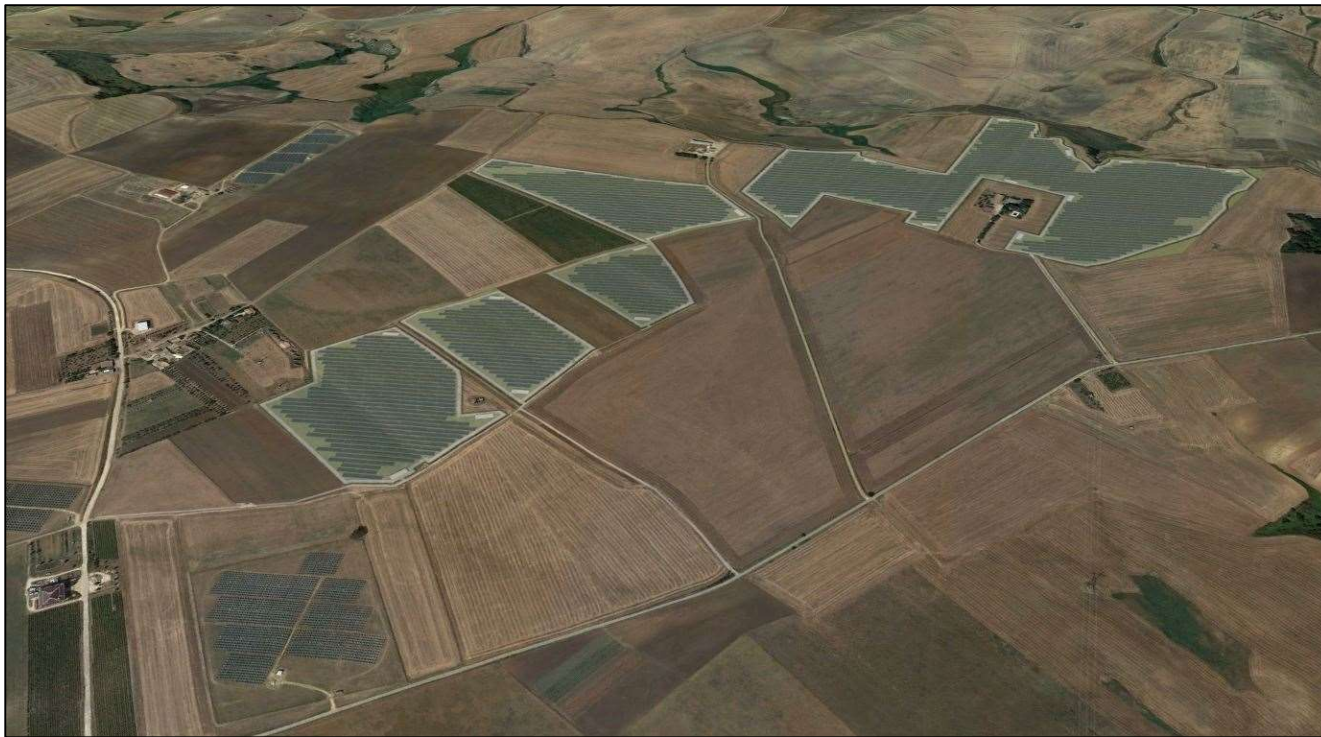
Panoramica D – Vista Est
