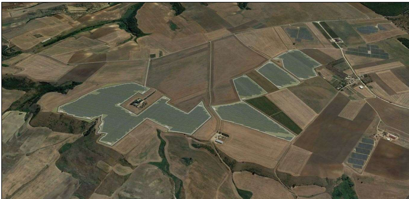
Panoramica B – Vista Ovest
