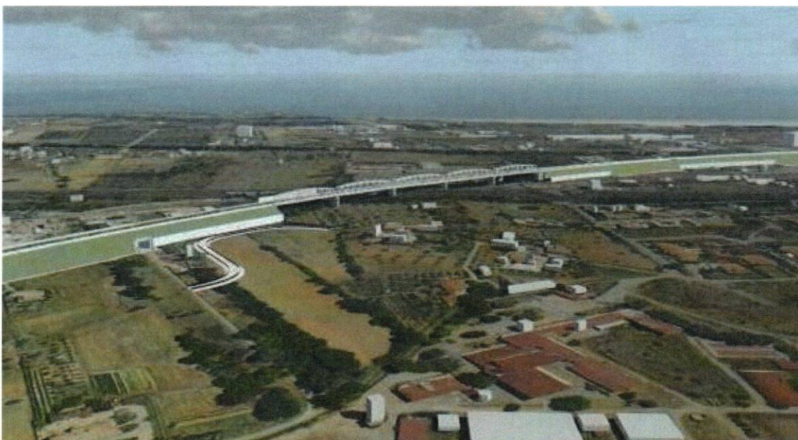
Figura 6 – Tratto di viadotto (VI01) in corrispondenza dell'Autostrada. Fotosimulazione
