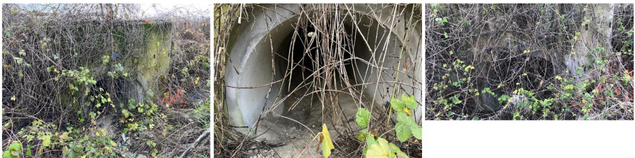
Figura 14 Foto del tombino stradale in demolizione
