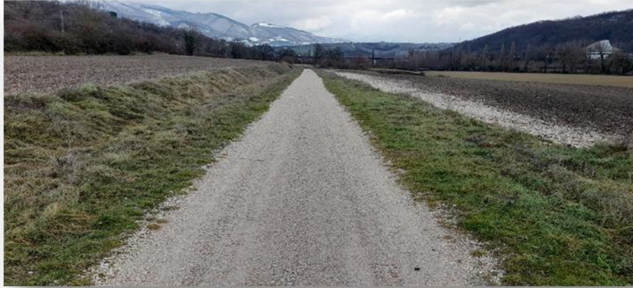
Figura 6 – Esempio di strada tipo in misto granulare
