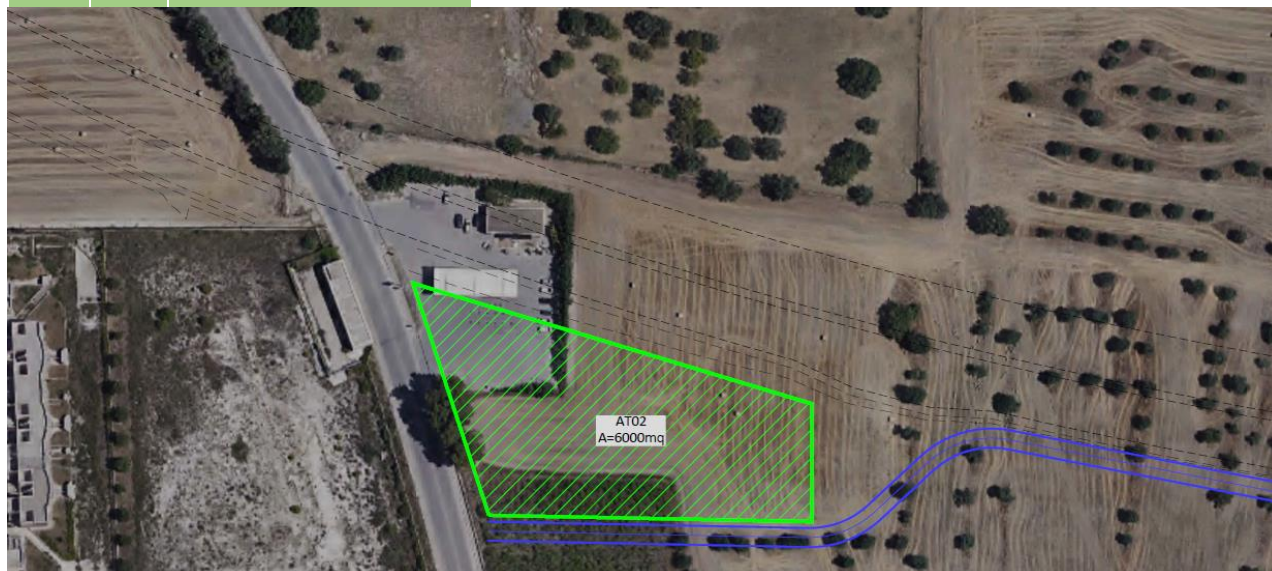
Figura 3-16: vista aerea area tecnica AT02
