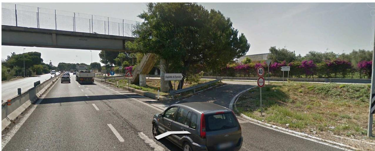
Figura 2: Vista di un'uscita – mancata protezione ostacoli fissi a bordo carreggiata
