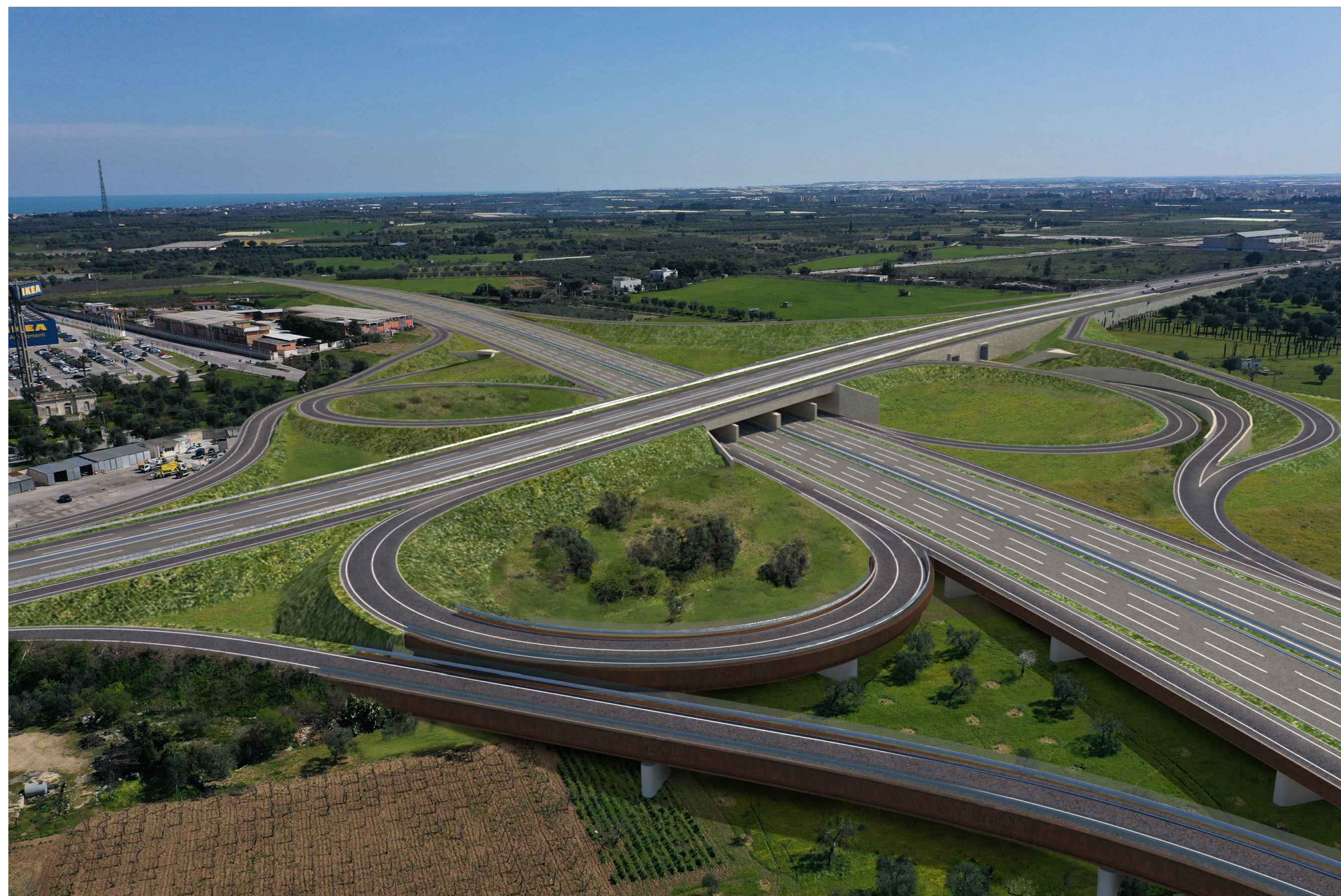
POST OPERAM Vista n.2 - Svincolo SV02 Mungivacca, in direzione Caldarola
