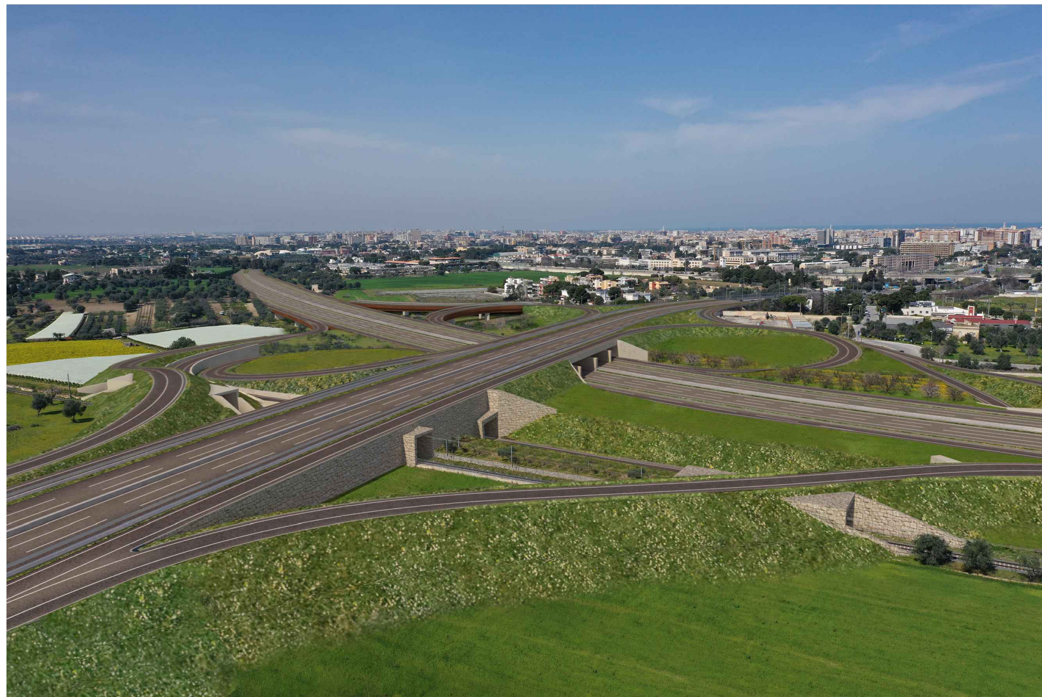
POST OPERAM Vista n.1 - Svincolo SV02 Mungivacca, in direzione Bari
