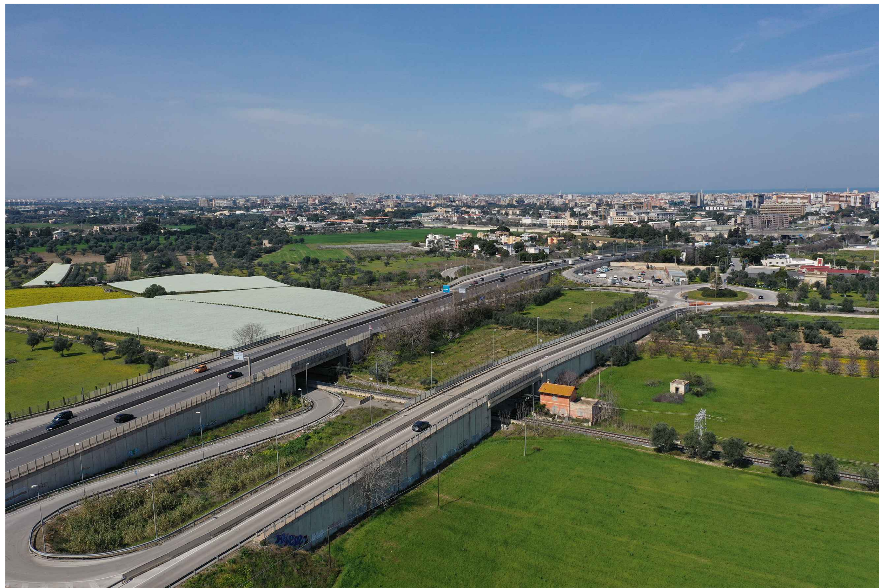
ANTE OPERAM Vista n.1 - Svincolo SV02 Mungivacca, in direzione Bari
