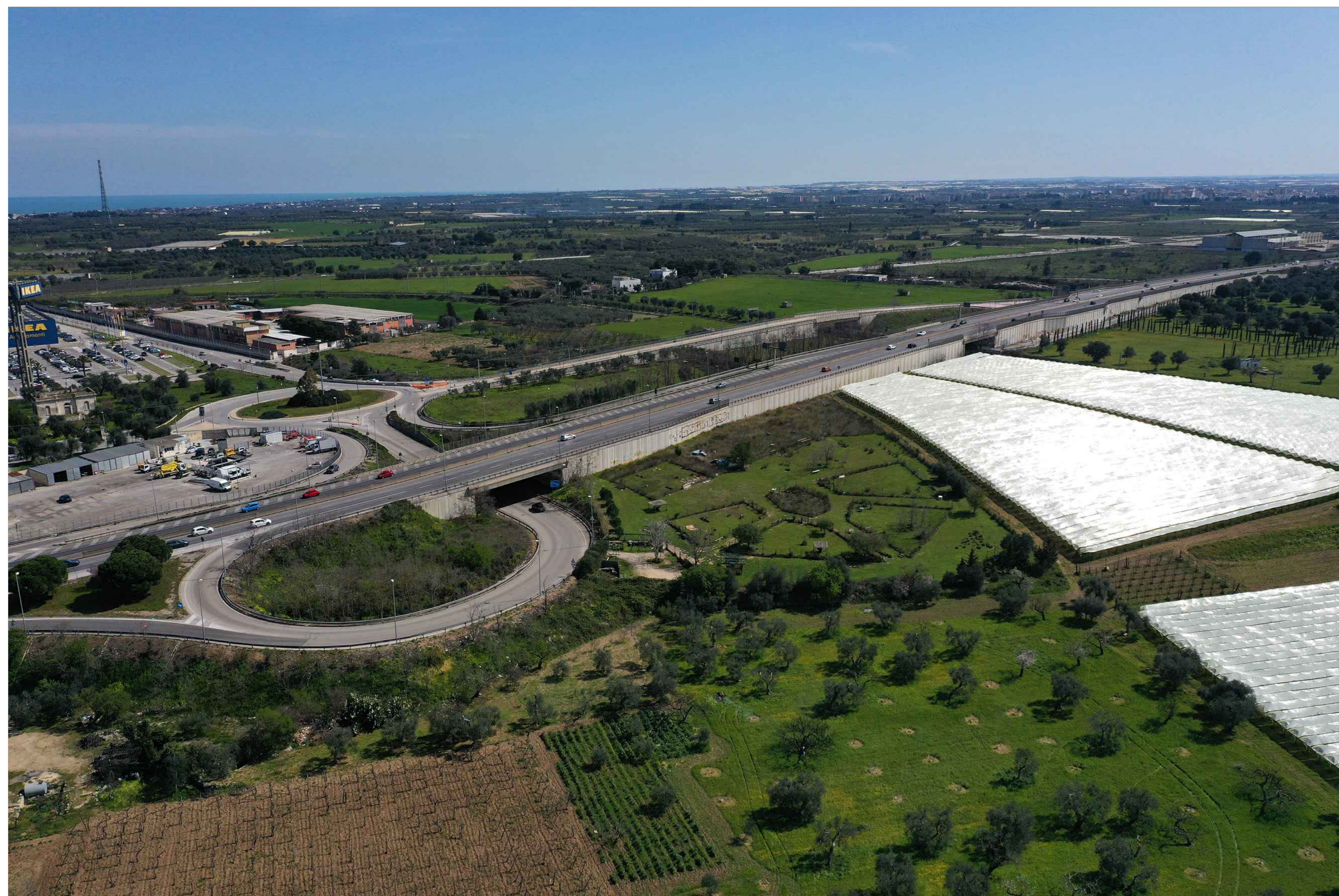
ANTE OPERAM Vista n.2 - Svincolo SV02 Mungivacca, in direzione Caldarola
