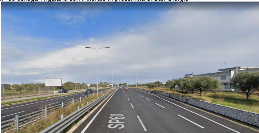
Figura 6: SP 60, direzione nord-est
