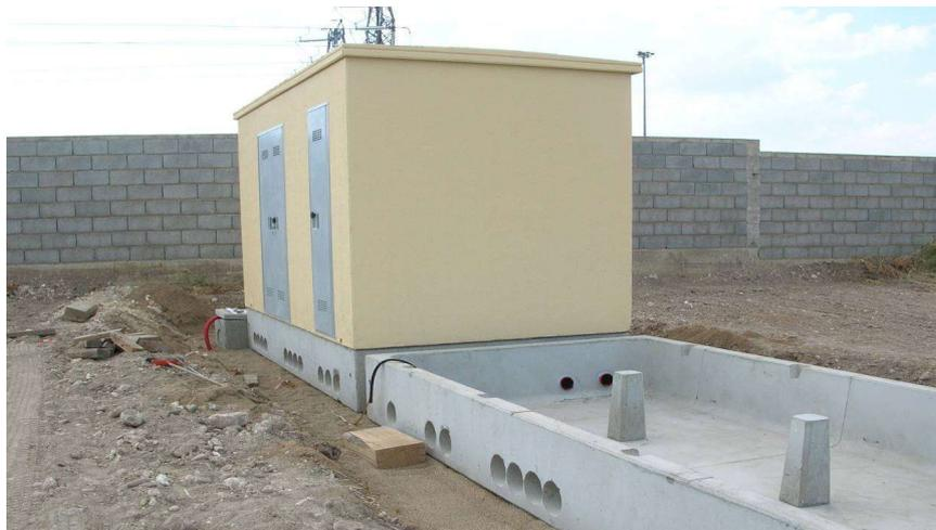
*Figura 7 - Cabine Elettriche Prefabbricate*
