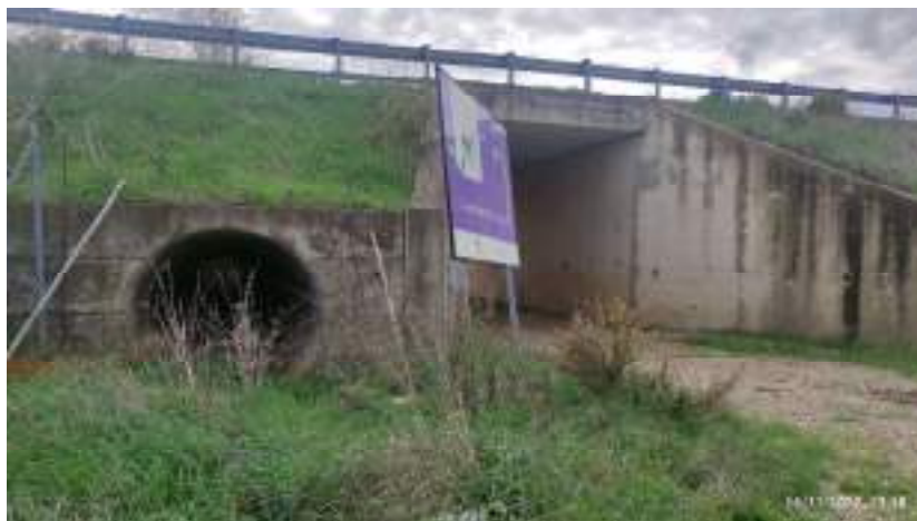
Foto scattate in corrispondenza del punto 20.
