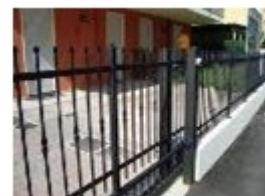
RECINZIONE E OPERE IN FERRO
