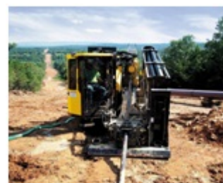
PERFORAZIONI MEDIANTE LA NO-DIG
