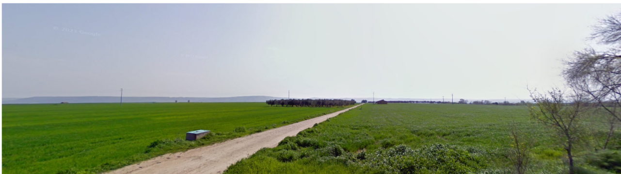
Figura 16: Vista dell'area d'impianto in prossimità dell'aerogeneratore T03 dalla SP n.45 angolo Strada Comunale delle Croci.
