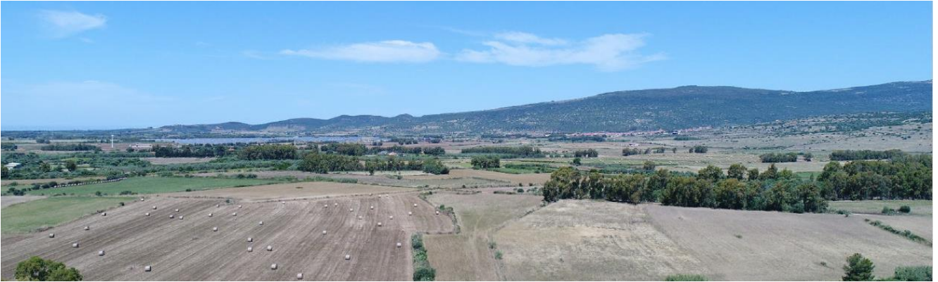
Fig. 15: area centrale del percorso dell'elettrodotto aereo
