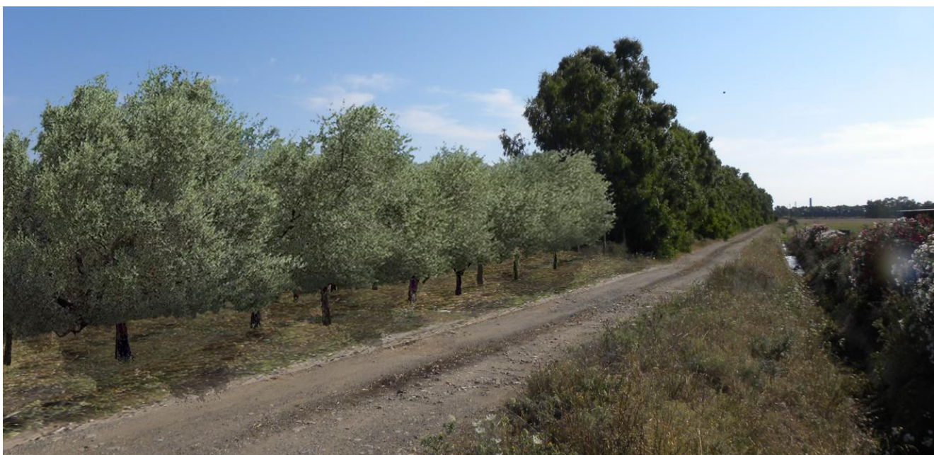
Fig. 52: Vista dall'ingresso del ricettore 1 da strada vicinale Spinarba post intervento
