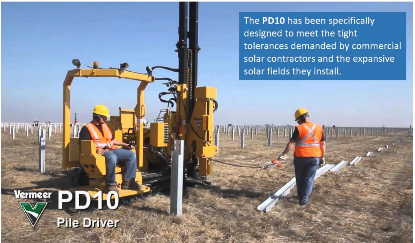
Fig. 6: Macchina battipalo (esempio)
