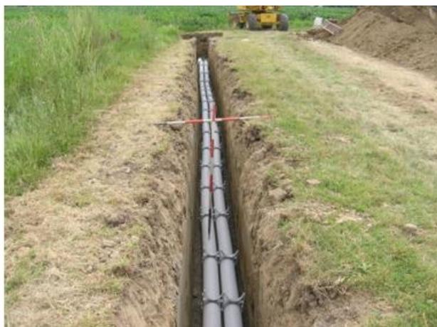
Fig. 1: cavidotti interrati (ESEMPIO)
