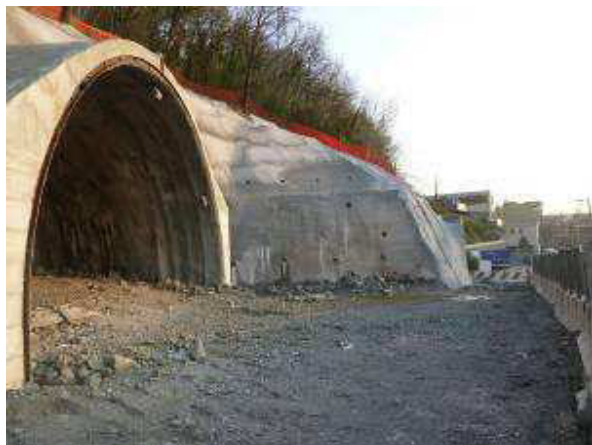
Figura_01 area interna di cantiere
