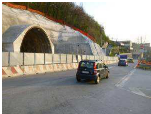
Figura_02 vista del cantiere dalla strada
