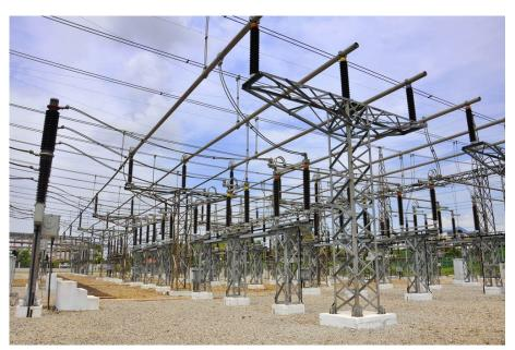
Esempio di sottostazione AT con equipaggiamenti installati su basamenti in c.a.
