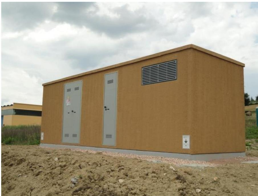
*Figura 2-10 Esempio di cabina prefabbricata in c.a. poggiata su basamento in c.a.*
