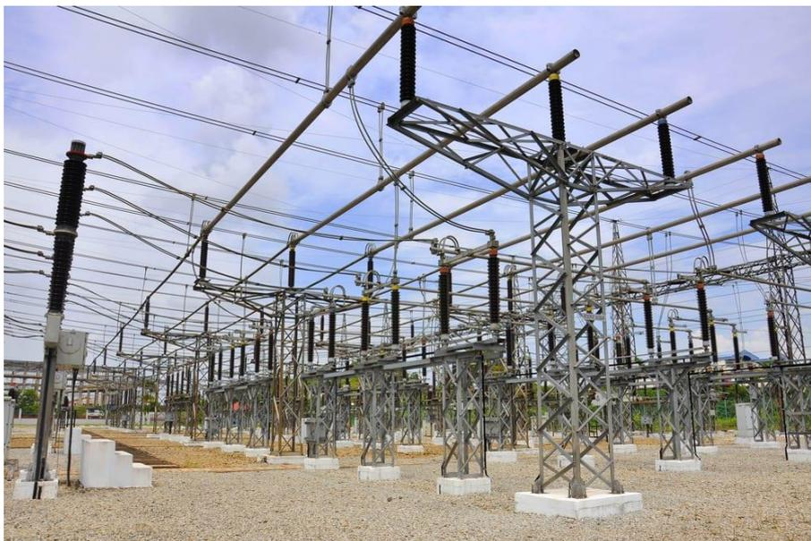
*Figura 2-6 Esempio di sottostazione AT con equipaggiamenti installati su basamenti in c.a.*
