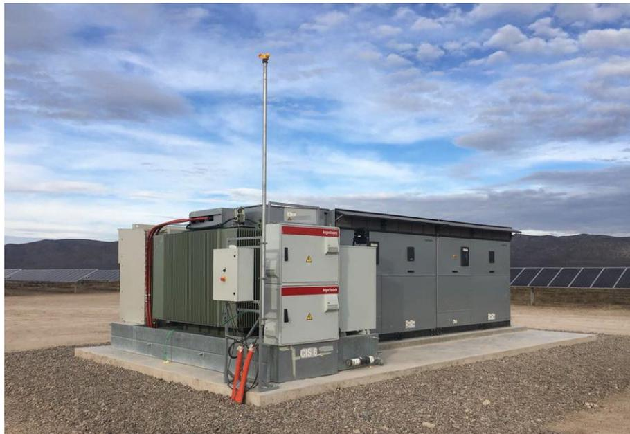
Figura 2-5 Esempio fotografico di inverter su basamento in c.a.
