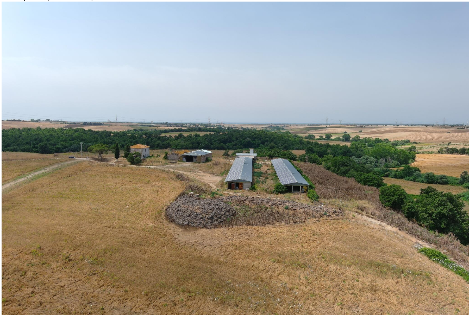
Foto 7 Punto di ripresa 5 (direzione sud)
