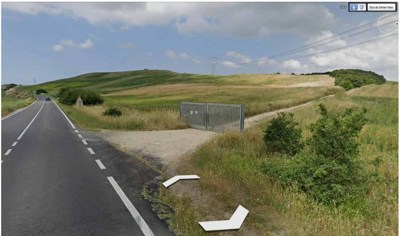
Figure 10 - Bivio di accesso al lotto
