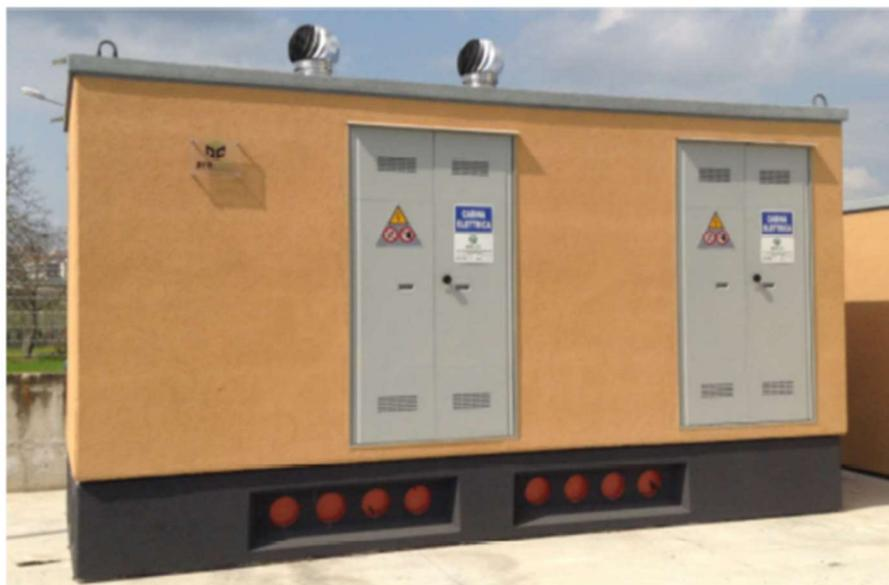
Rappresentazione di una tipica cabina di sezionamento secondo DG2061 con vasca di fondazione
