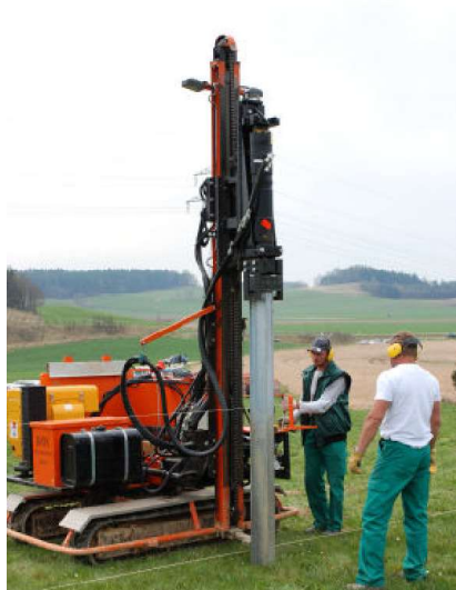
Infissione dei pali delle strutture con macchina idraulica battipalo
