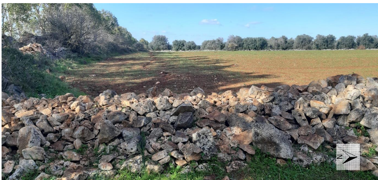
Fig. 23. Il muretto a secco a oriente del campo 6 e, sulla sinistra, i blocchi del “Paretone”.
