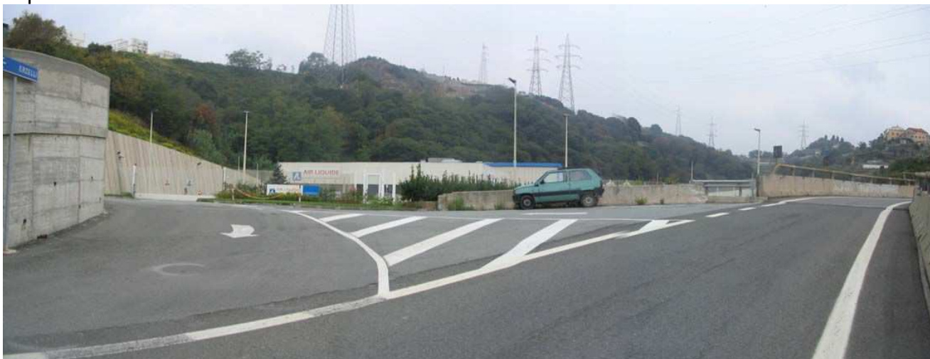
Fig. 1 : Area del COV 2 stato di fatto
