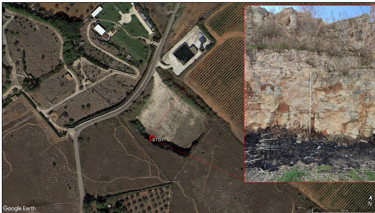
Rilievo geomeccanico ZONA 1
