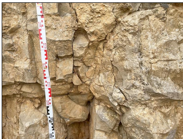
Rilievo geomeccanico ZONA 1
