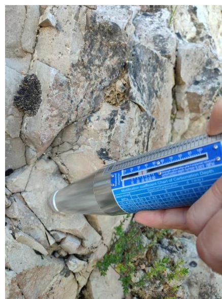
Rilievo sclerometrico ZONA 2
