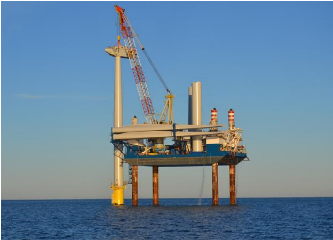
Figura 9 Struttura per l'infissione dell'aerogeneratore
