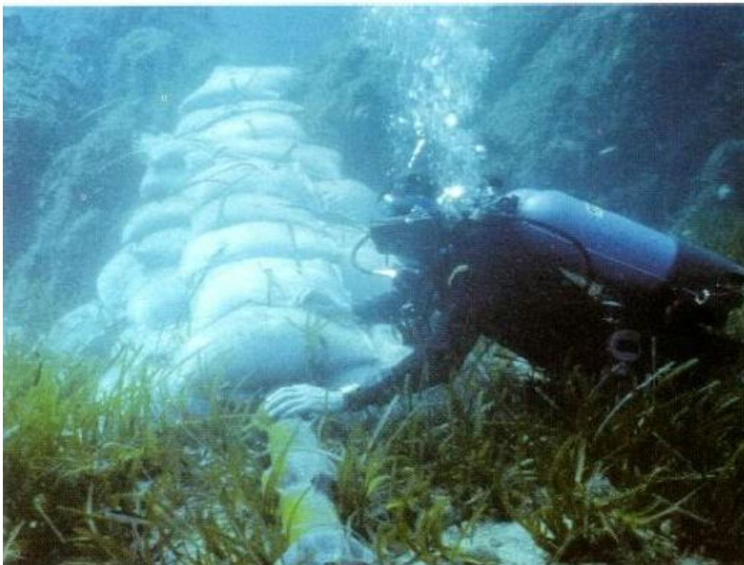
Figura 6: fase di posizionamento dei materassi in calcestruzzo
