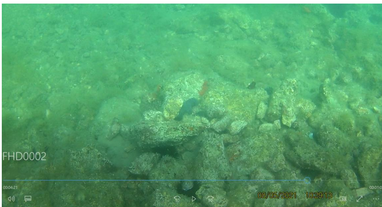
Figura 17 - Esame visivo acqua e fondale sottostante
