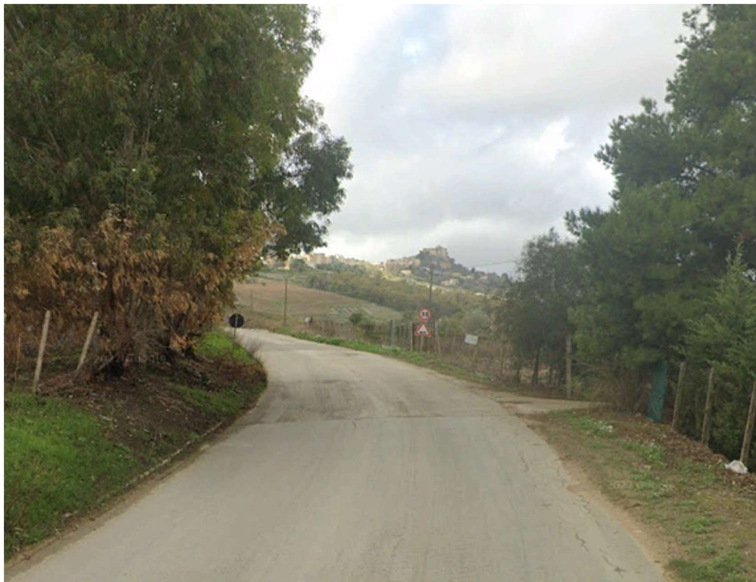
Fig.36_ SP12 interessata dalla posa dell'elettrodotto di connessione alla rete
