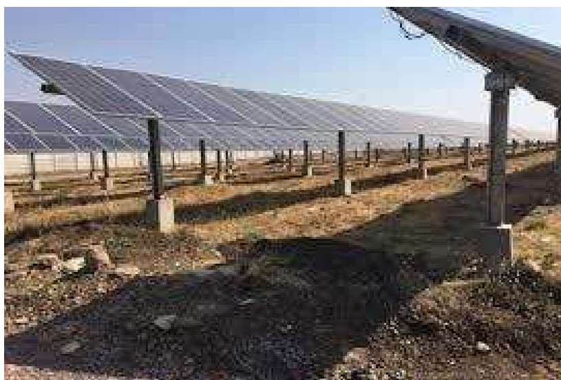
Fig.57 _ Esempio di impianto fotovoltaico con fondazioni ottenute mediante perforazione del terreno e successiva creazione del palo di fondazione con getto di cemento
