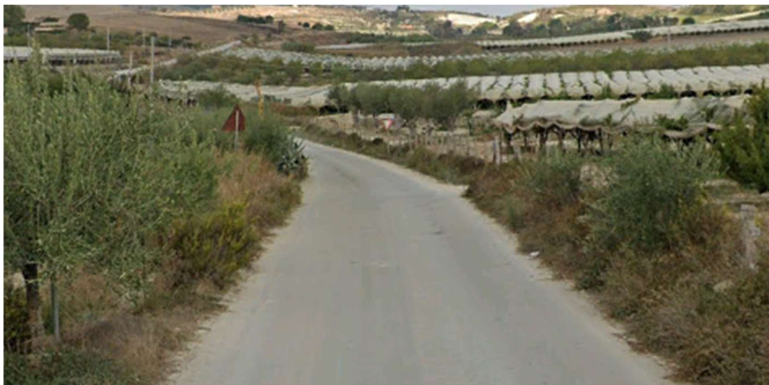
Fig.34 _ SPC 59 interessata dalla posa dell'elettrodotto di connessione alla rete
