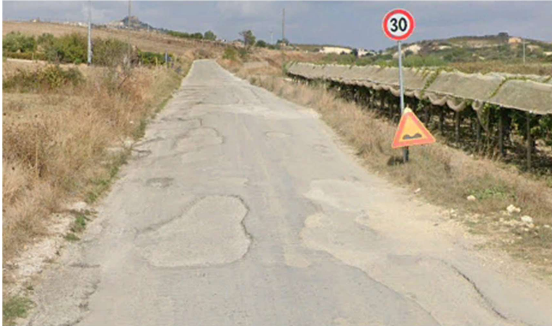
Fig. 35_ SP46 interessata dalla posa dell'elettrodotto di connessione alla rete
