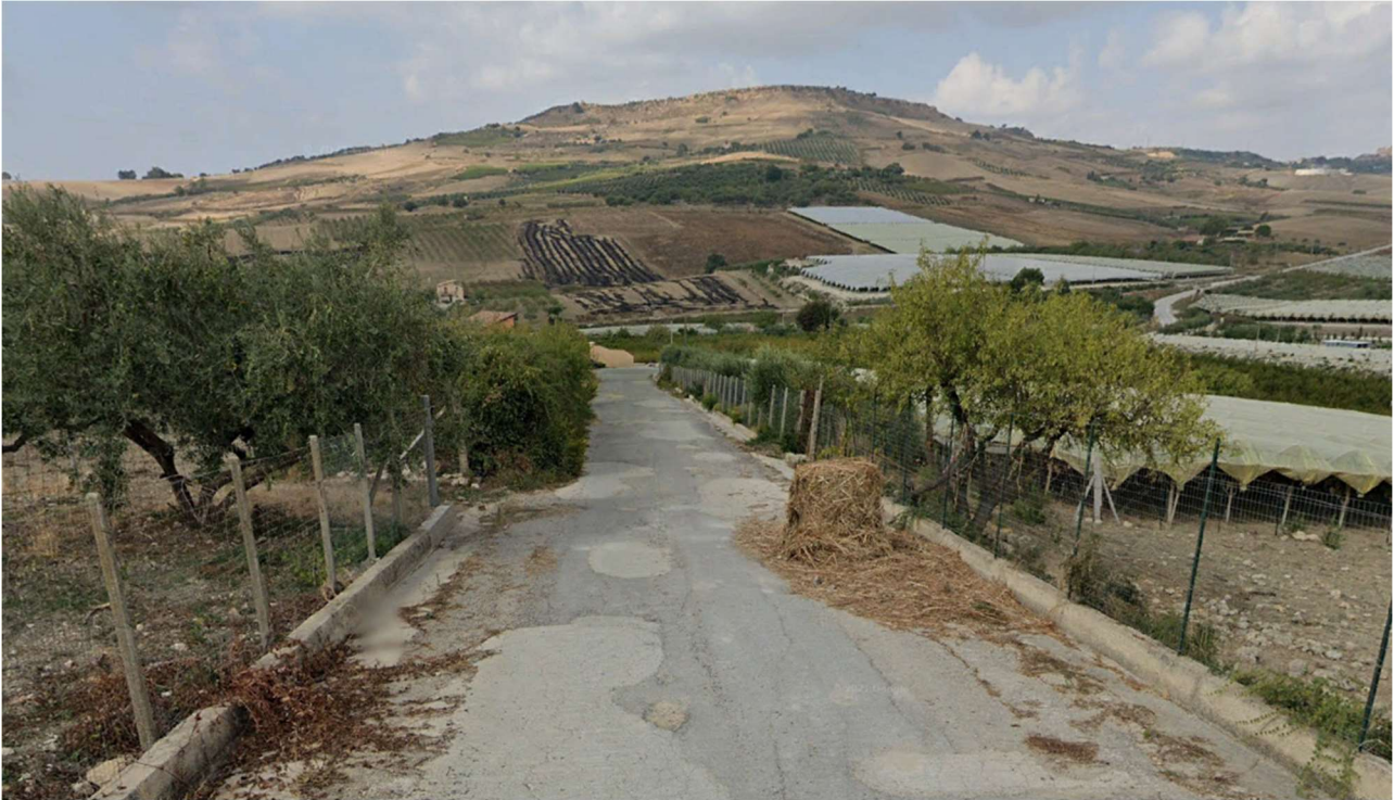
Fig.33 _ Strada privata nella disponibilità del proponente, interessata dalla posa dell'elettrodotto di connessione alla rete
