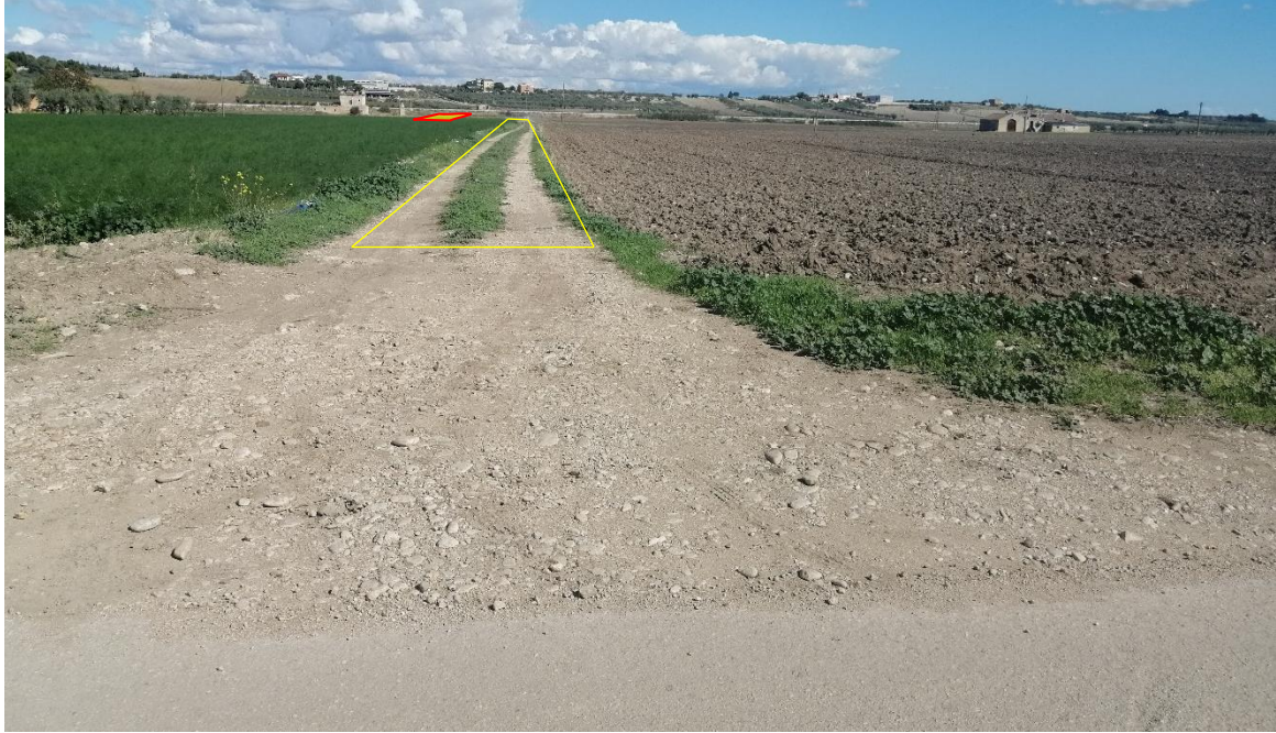
Foto n. 17 - Strada di accesso all'impianto PIDI n.2 dalla strada vicinale Pontalvanito Santa
