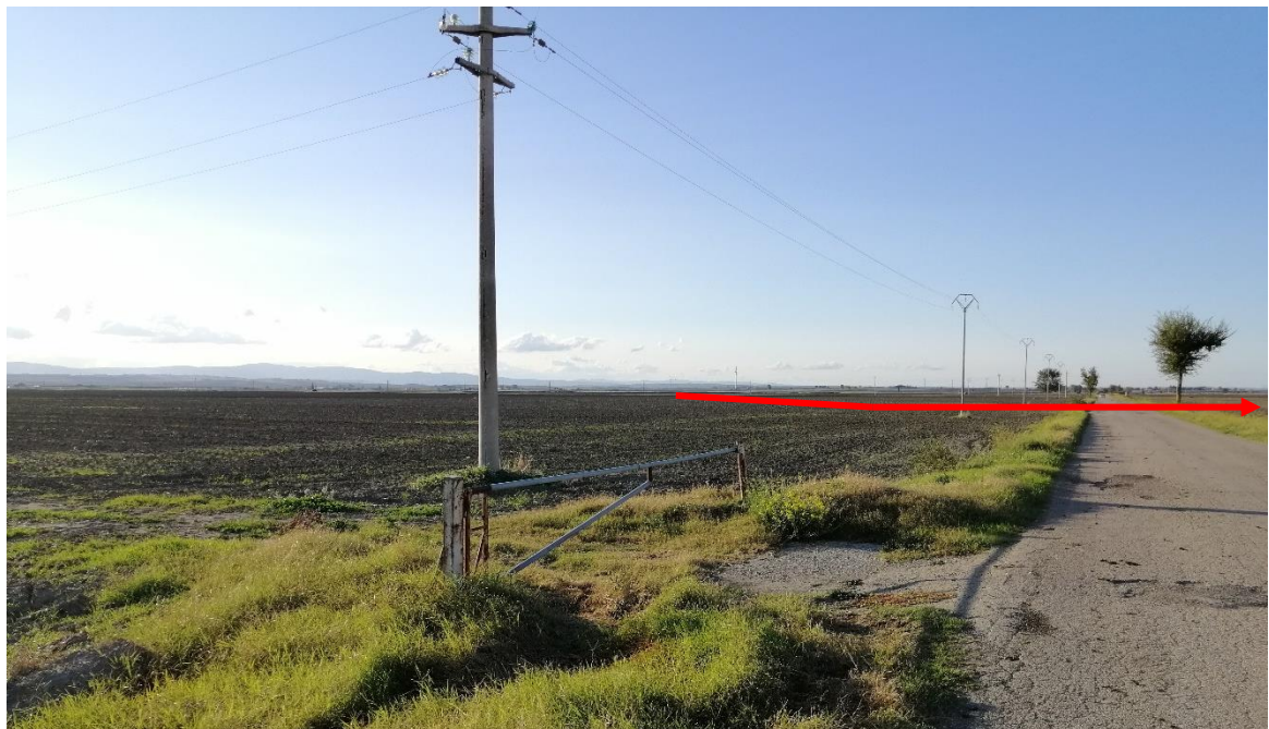
Foto n. 54 – Panoramica contro senso-gas a monte dell’attraversamento della strada provinciale n.13 (attraversamento area agricola)
