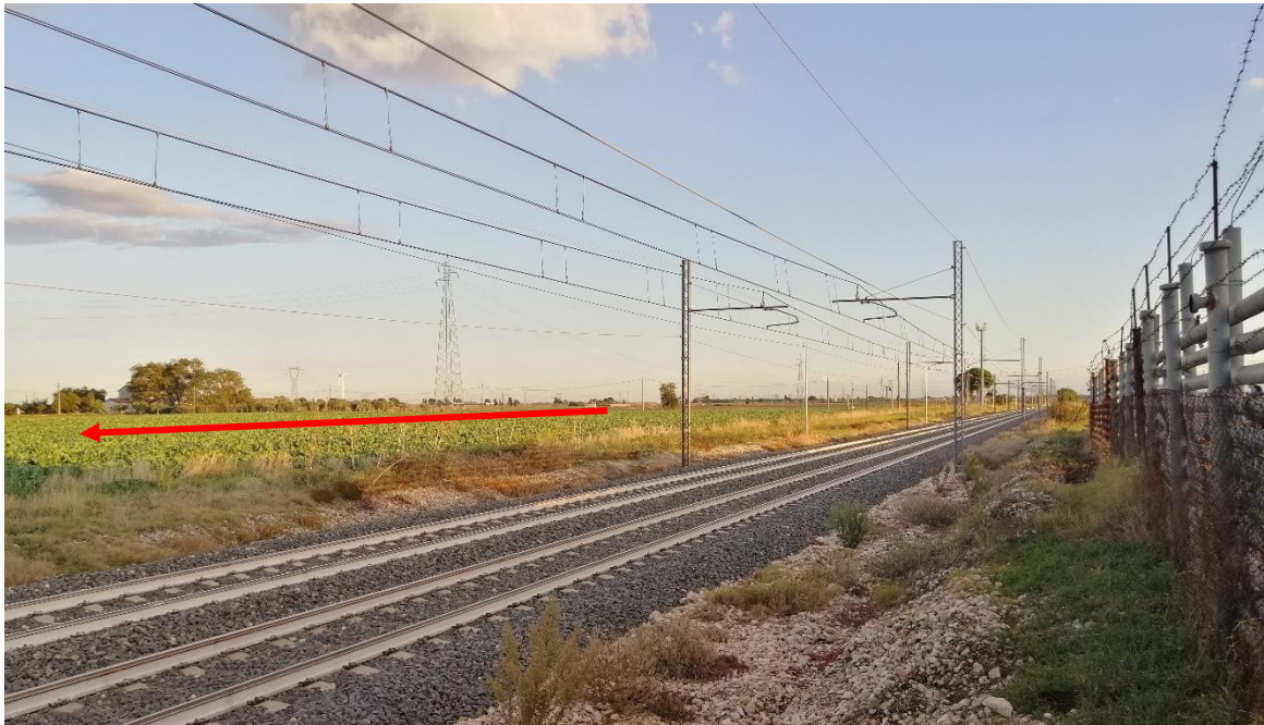
Foto n. 68 - Panoramica contro senso-gas a valle dall'attraversamento ferroviario (tratto in parallelismo alla Ferrovia Adriatica)
