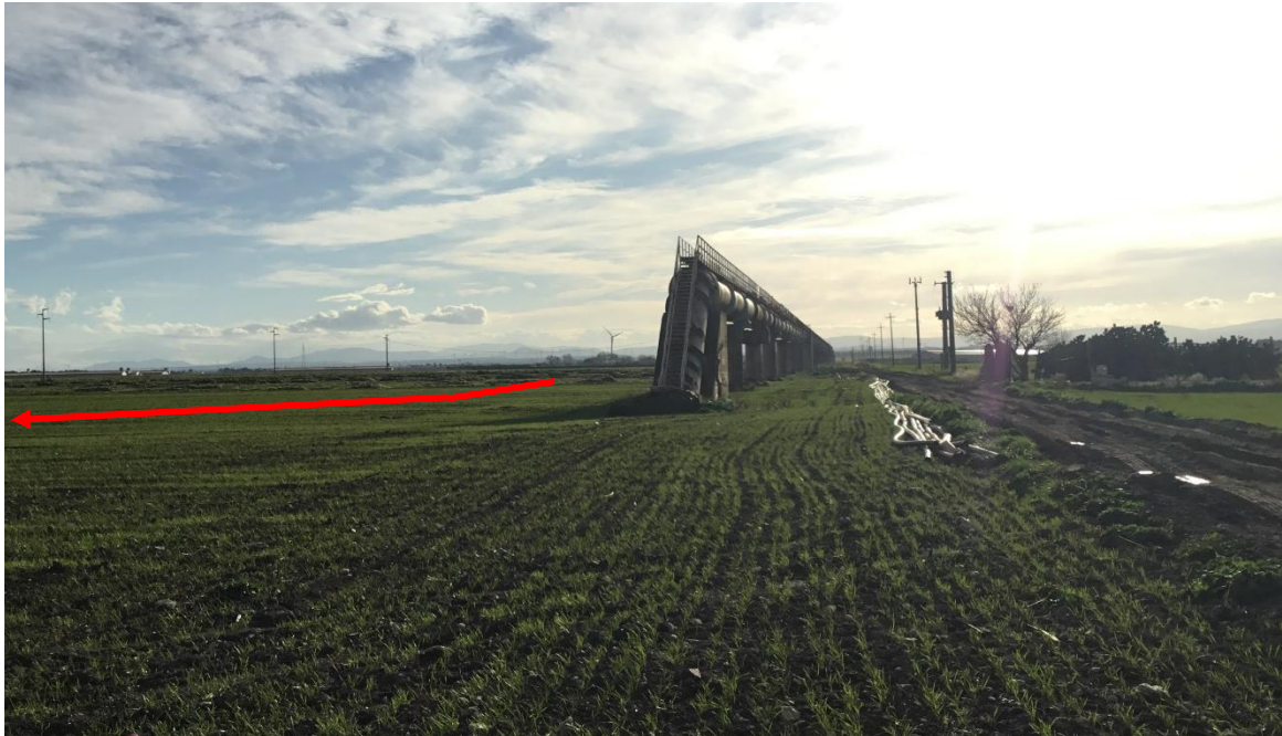
Foto n. 45 – Panoramica contro senso-gas (attraversamento area agricola – parallelismo con acquedotto fuori terra)
