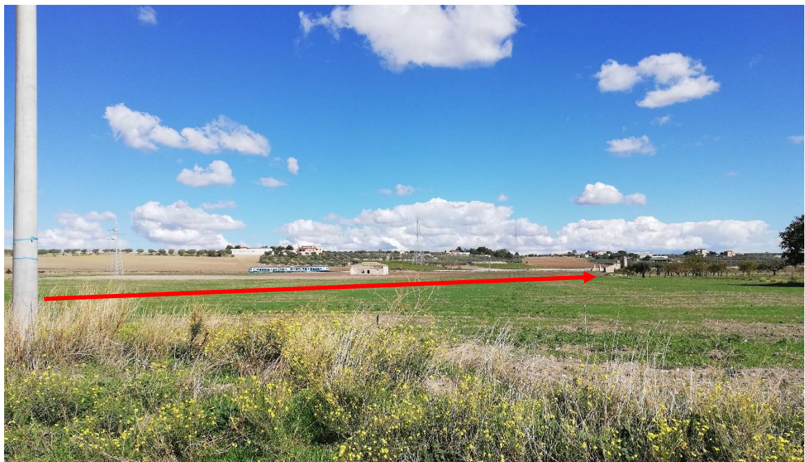
Foto n. 14 – Panoramica senso-gas vista dalla strada vicinale Pontalvanito Santa (attraversamento area agricola)
