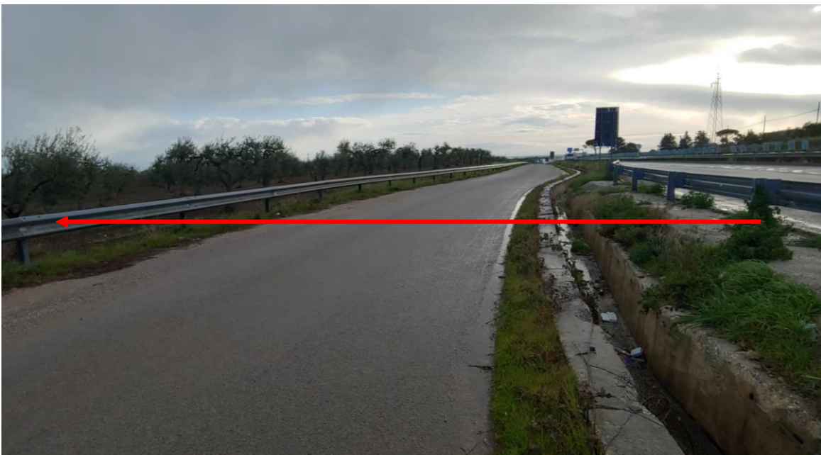
Foto n. 26 – Attraversamento complanare Nord (strada parallela alla statale n.17)
