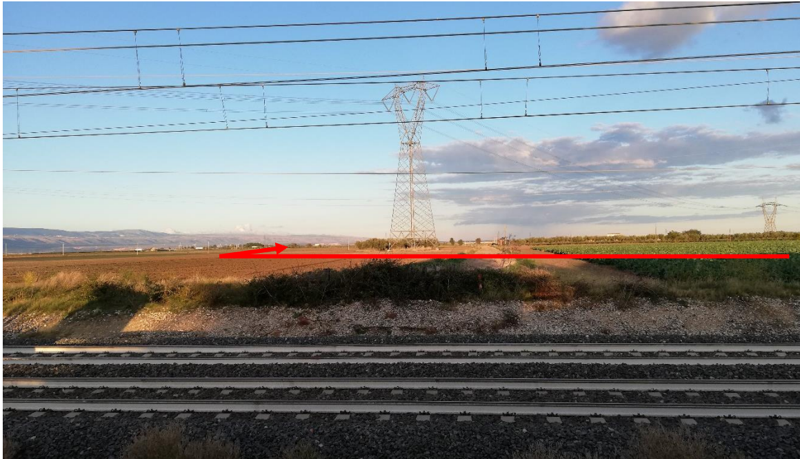
Foto n. 69 – Panoramica senso-gas a valle dall’attraversamento ferroviario (attraversamento area agricola e della strada n.20 Bonafica)
