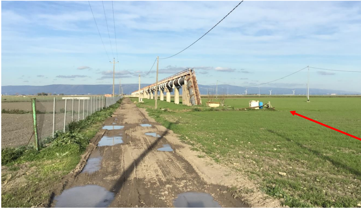
Foto n. 43 – Panoramica senso gas tratto in parallelismo con l’acquedotto fuori terra
