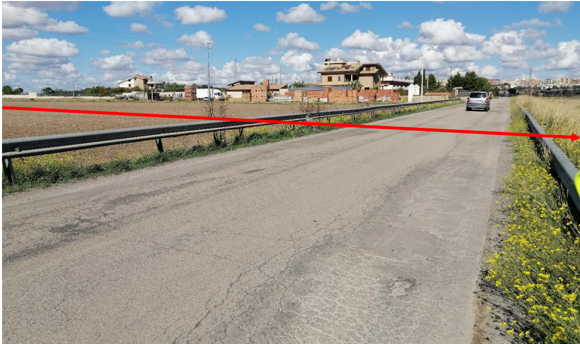
Foto n. 7 – Attraversamento strada provinciale n.109
