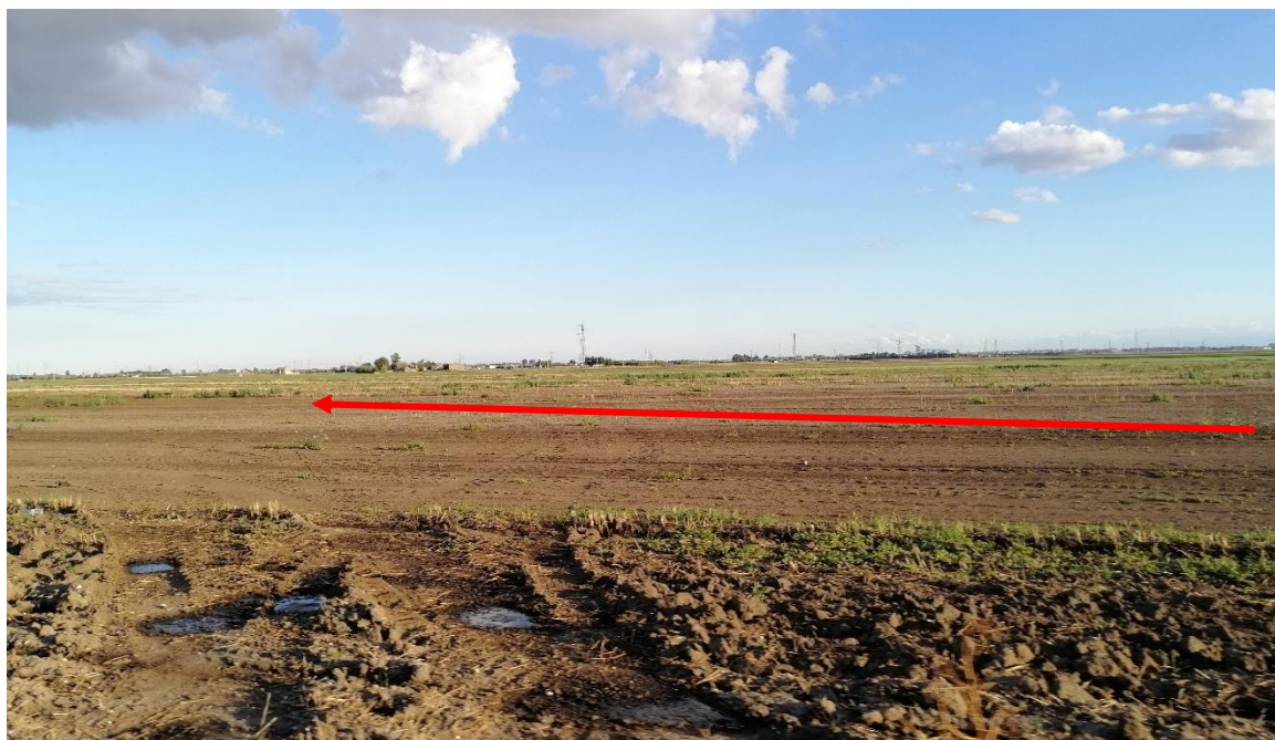
Foto n. 62 – Panoramica contro senso-gas e area adibita a piazzola di stoccaggio tubazioni (attraversamento area agricola)
