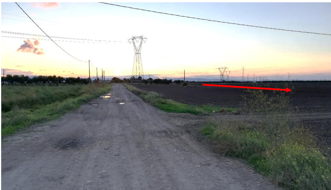
Foto n. 70 – Panoramica contro-senso gas nei pressi dell’impianto n.6 (attraversamento area agricola)
