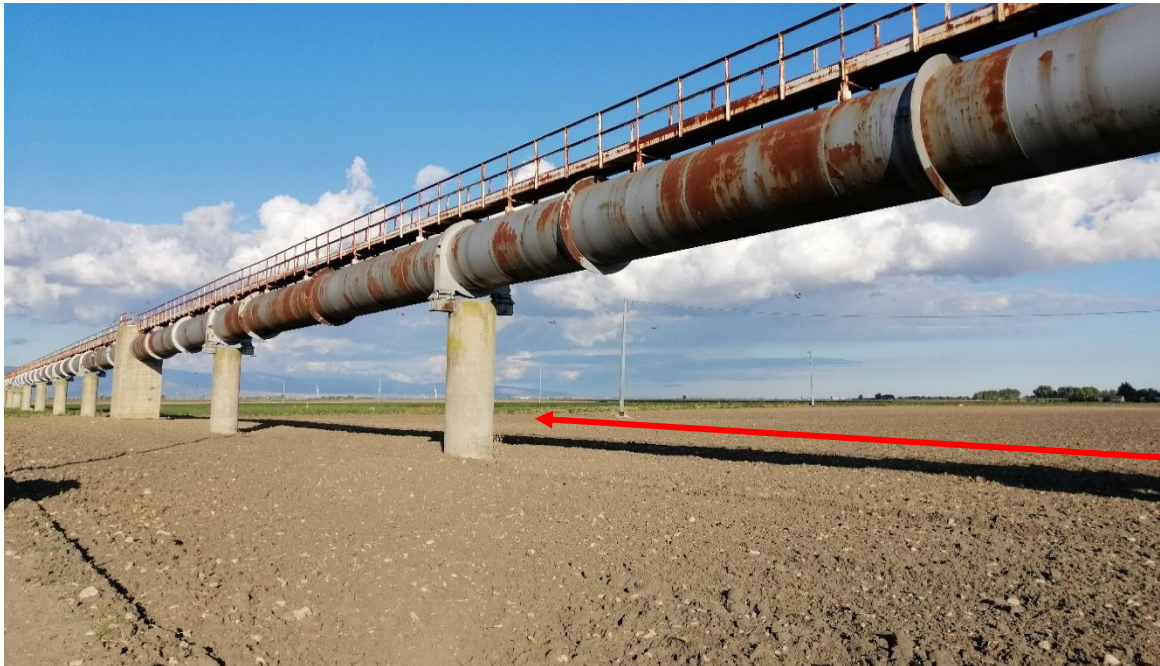
Foto n. 44 – Panoramica senso gas (attraversamento area agricola, tratto in parallelismo con l’acquedotto fuori terra)
