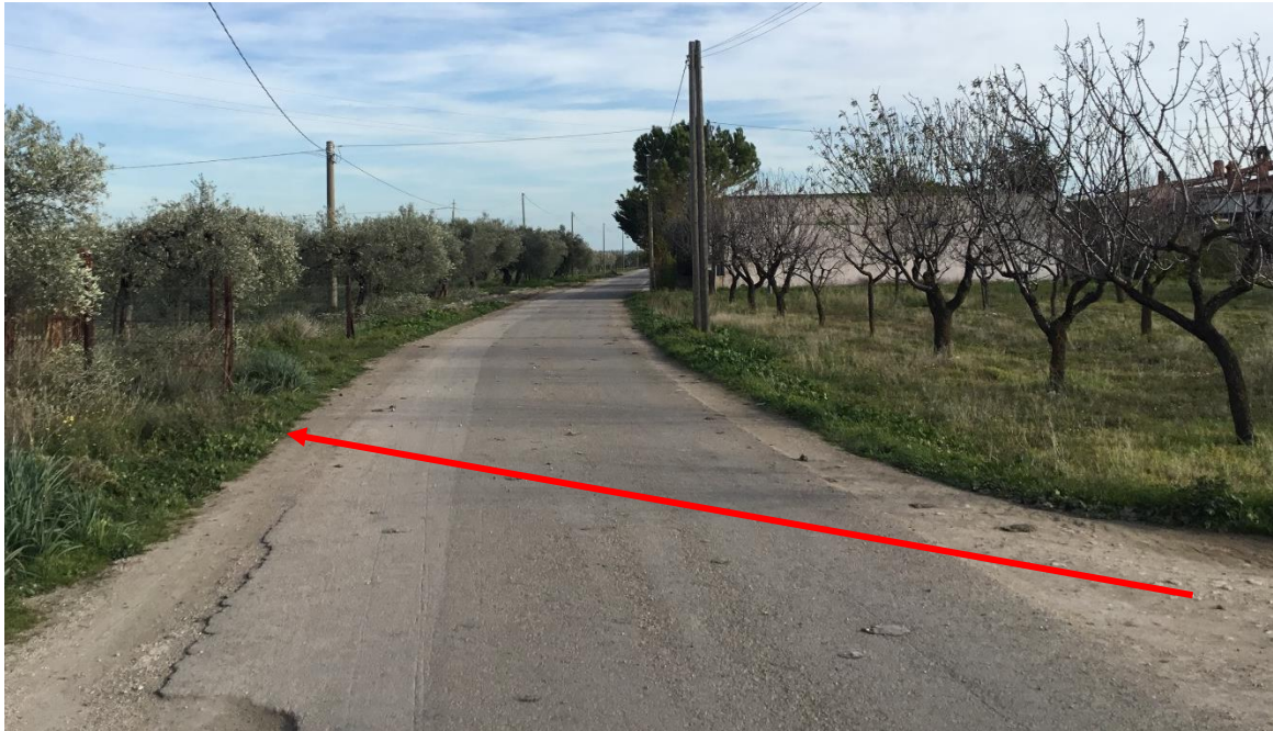
Foto n. 21 – Attraversamento strada vicinale Perazzo
