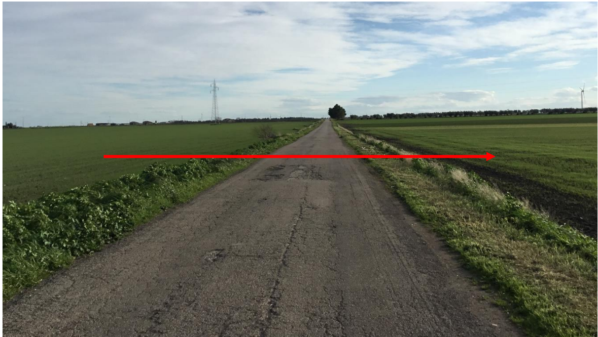
Foto n. 36 – Attraversamento strada provinciale n.118
