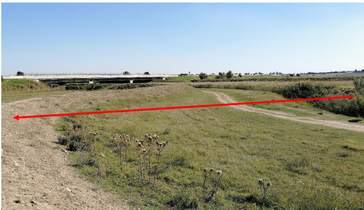
Foto n. 16 – Attraversamento Torrente Salsola e relativa area golenale (panoramica contro senso-gas)
