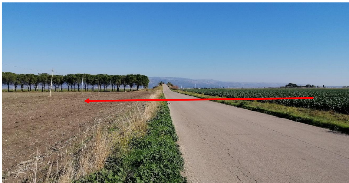
Foto n. 20 – Attraversamento strada provinciale n.22
