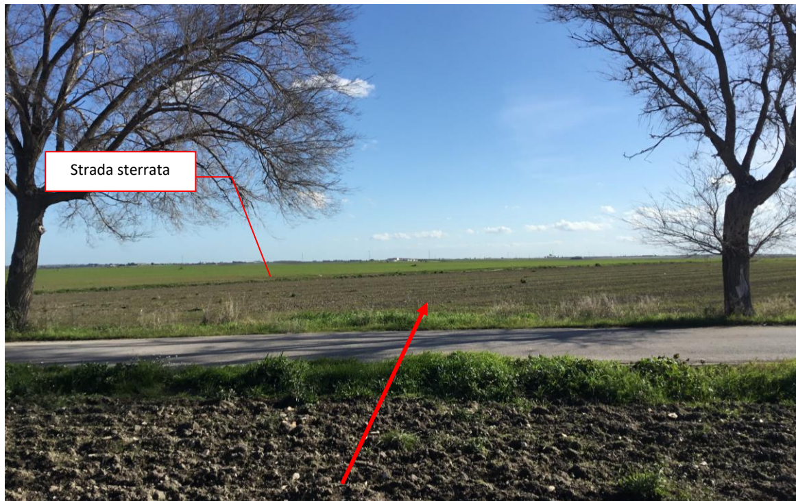
Foto n. 10 – Vista senso gas Attraversamento della Strada asfaltata SP n.23 “Nicola Spreccacenerè”
