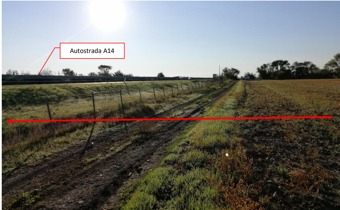
Foto n. 7 –Attraversamento strada in terra battuta ed ingresso trivellazione Autostrada A14
