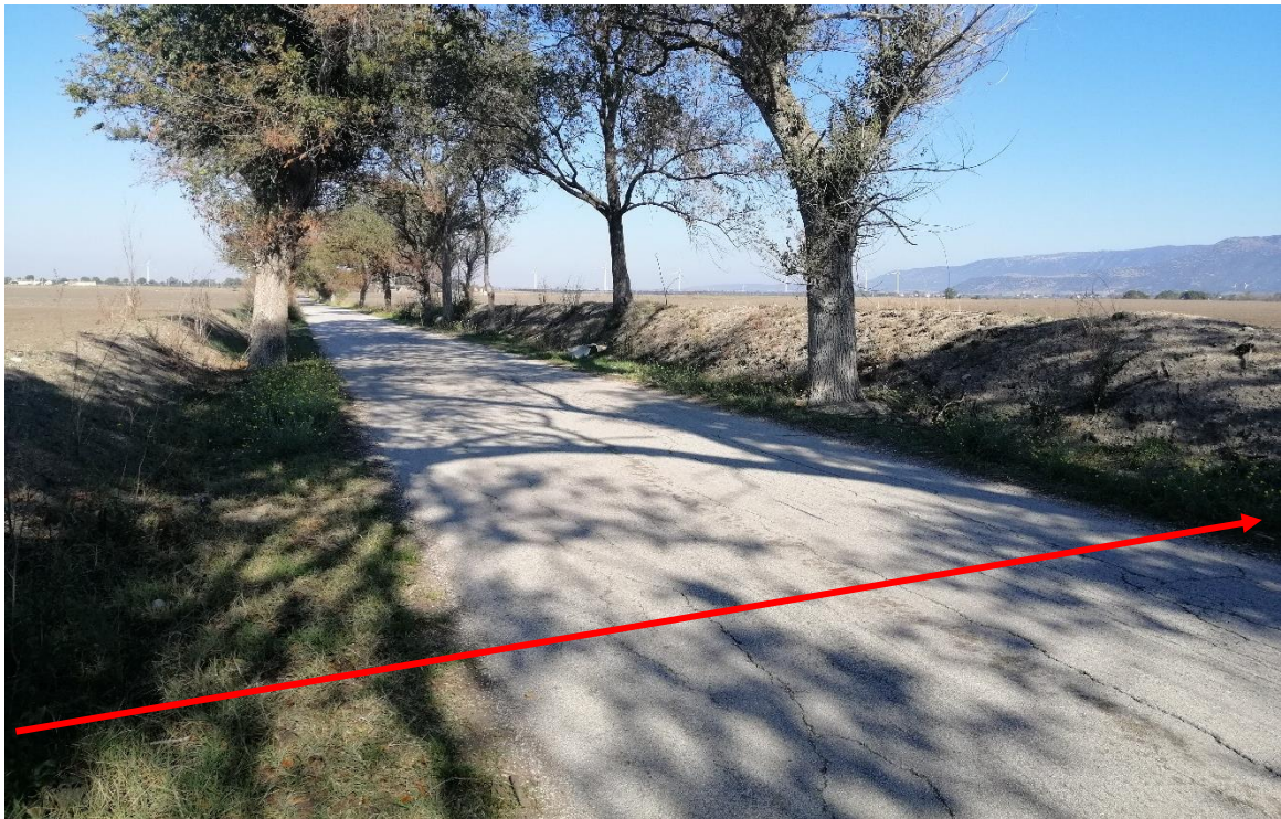
Foto n. 10 - Attraversamento Strada Provinciale n°24
