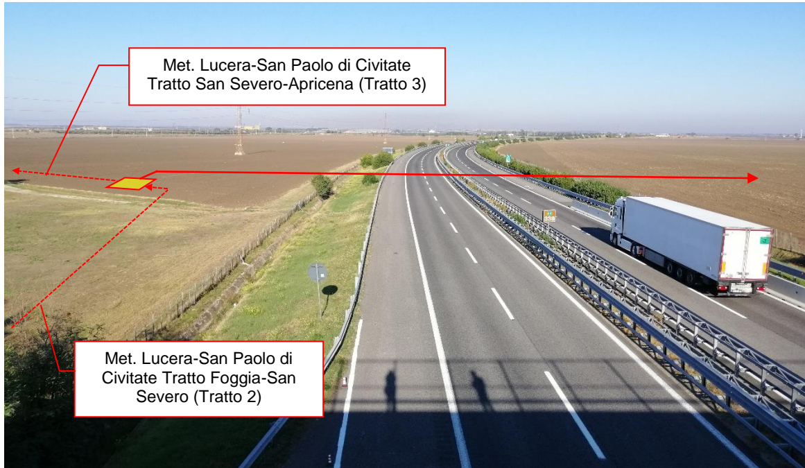
Foto n. 1 - Attraversamento autostrada A14
