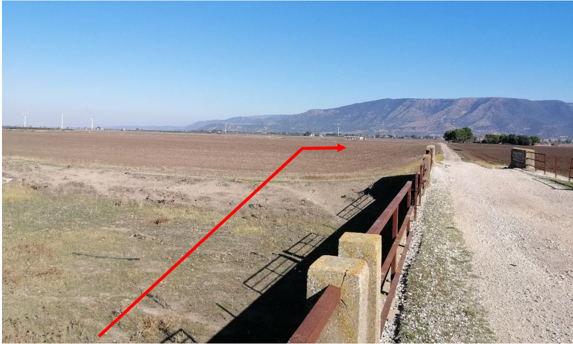
Foto n. 15 – Panoramica senso-gas a valle dell'attraversamento argine in sinistra idraulica del torrente Triolo e attraversamento strada sterrata
