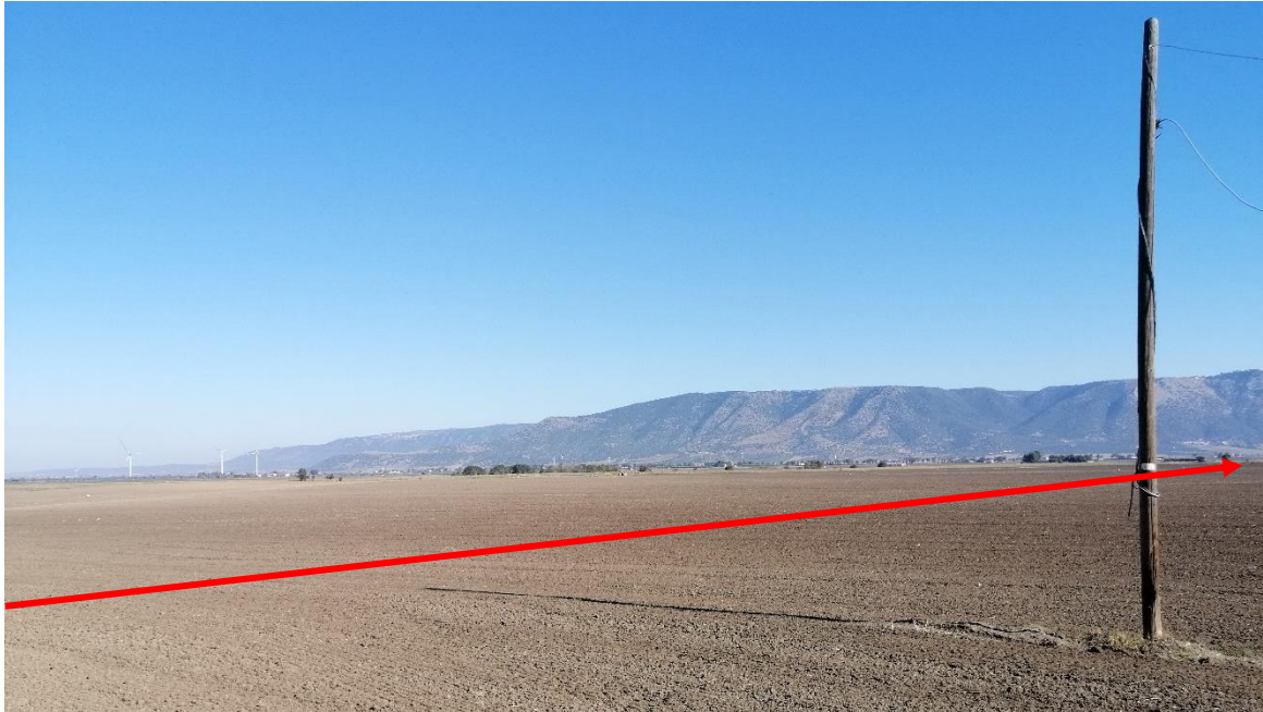
Foto n. 11 – Panoramica senso-gas a valle dell'attraversamento della S.P. 24
