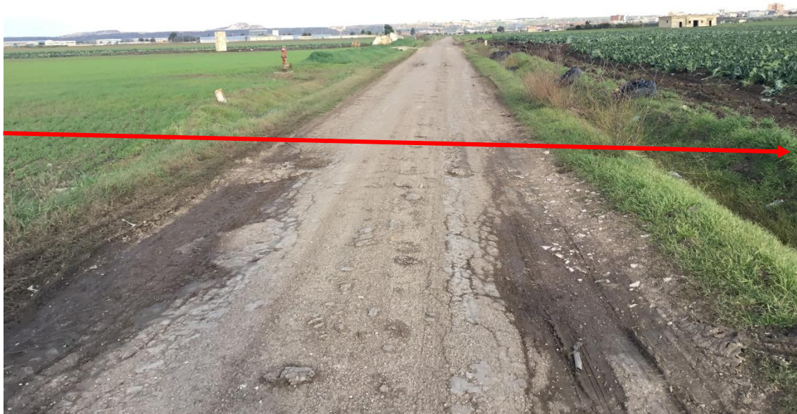
Foto n. 20 – Attraversamento Strada Comunale "Contrada Imperatore"
