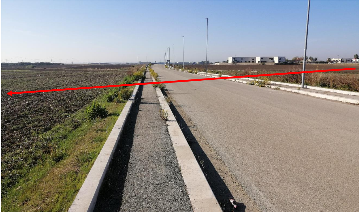
Foto n. 11 – Attraversamento strada asfaltata
