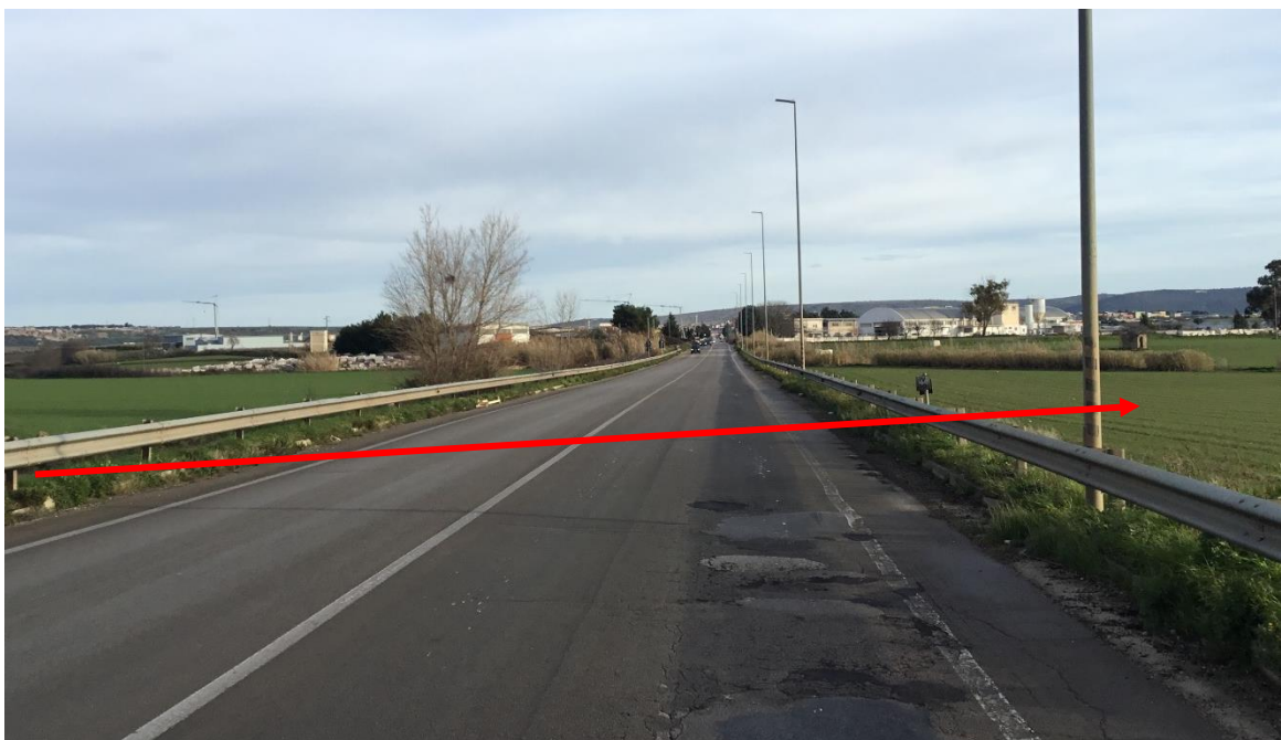
Foto n. 8 – Attraversamento Strada Statale n.89
