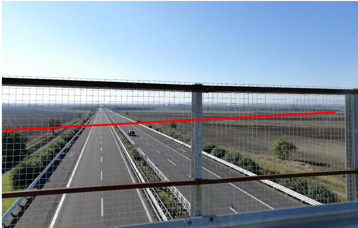
Foto n. 5 – Attraversamento Autostrada A14
