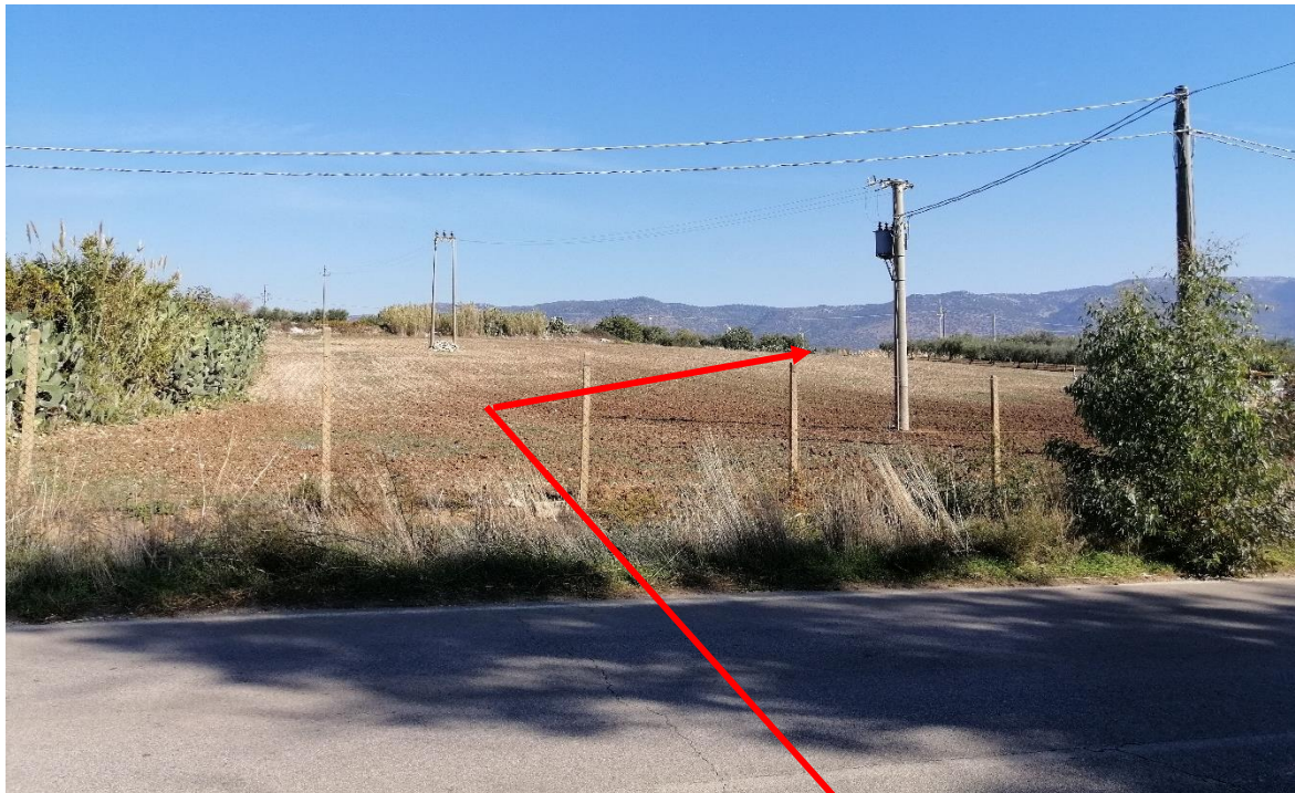
Foto n. 26 – Panoramica senso-gas a valle dell'attraversamento Strada Provinciale n° 28
