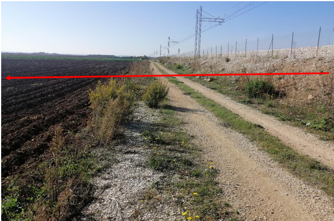
Foto n. 14 – Attraversamento stradina sterrata a valle dell'attraversamento ferroviario
