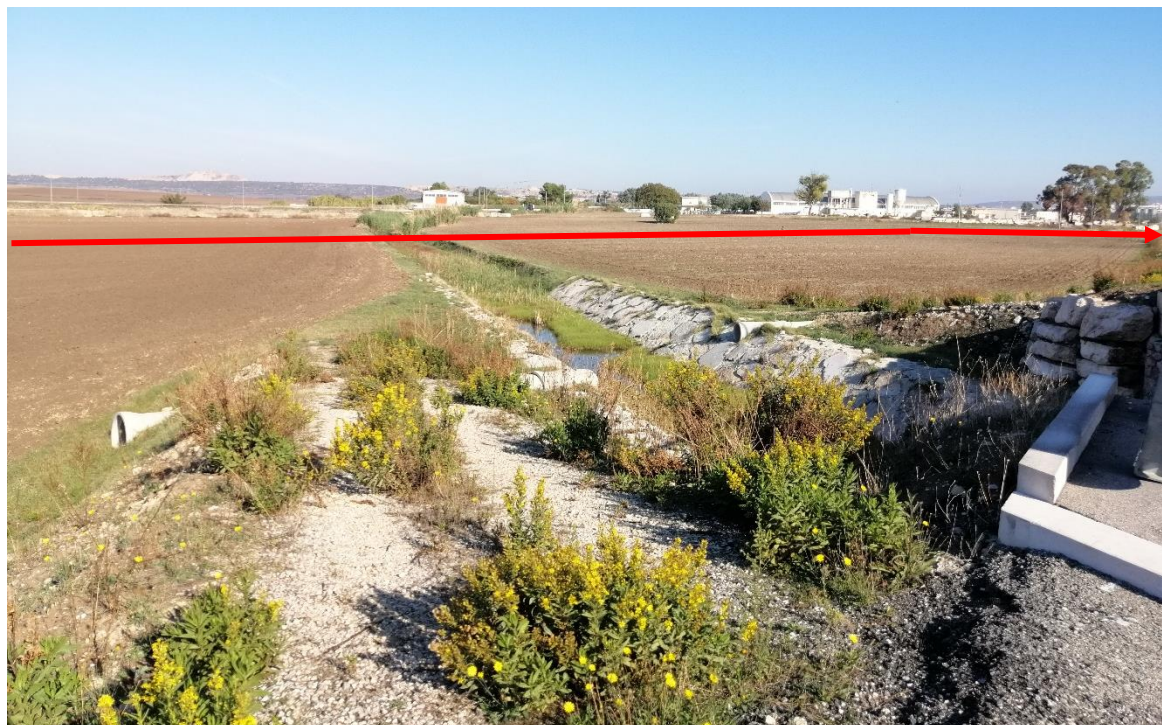
Foto n. 10 – Attraversamento Torrente Santa Lucia (Ex Canale San Martino)
