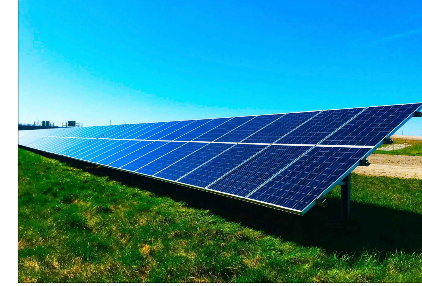
Esempio di sviluppo stringa con tracker 2P
