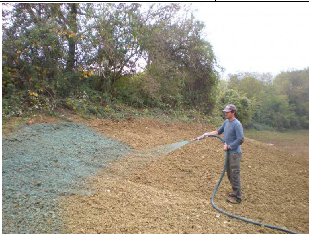
Fig. Esempio di inerbimento tramite idrosemina.
