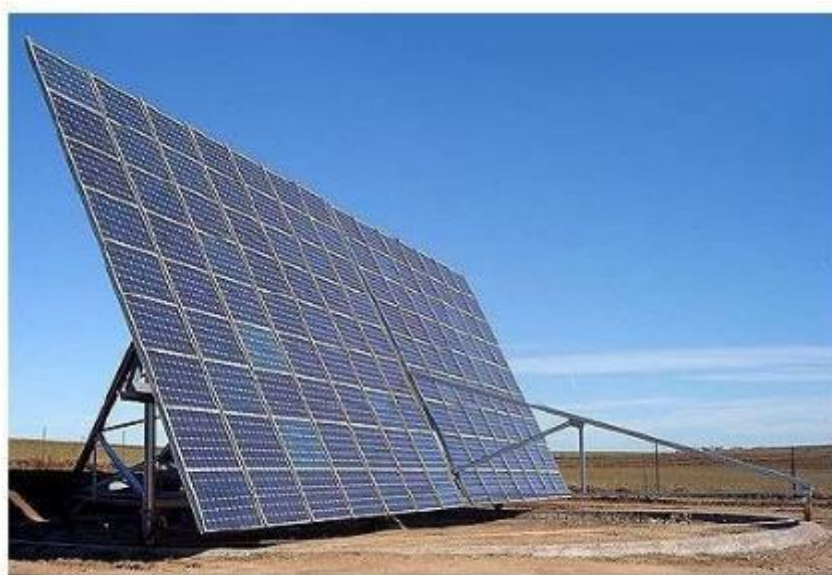
Figura 3.2-2 Inseguitori Azimut- elevazione
