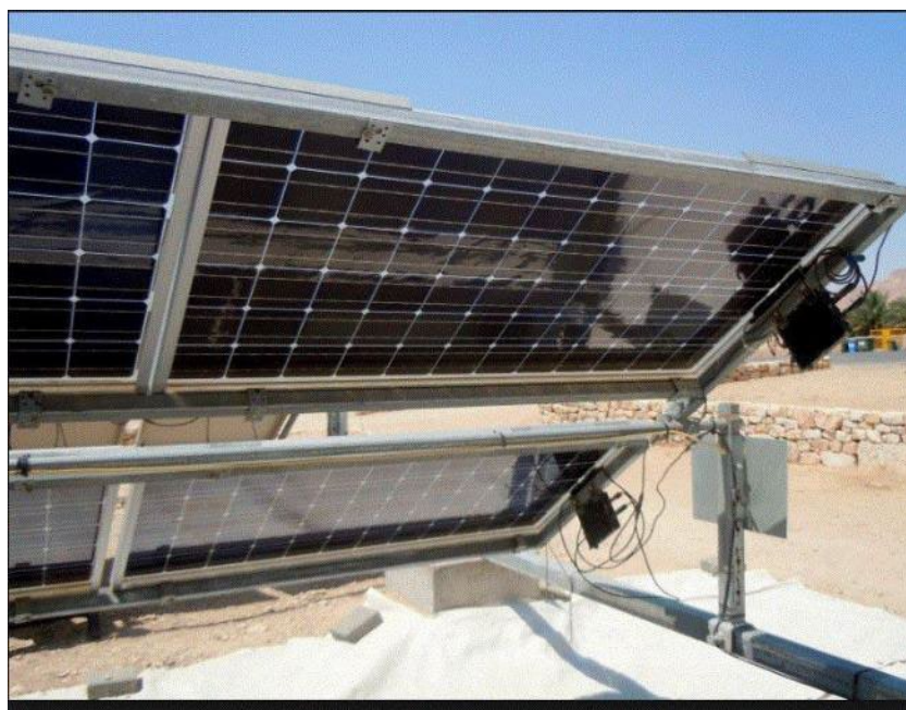
Fig. 5.1-1 Tipico Modulo fotovoltaico Bifacciale
