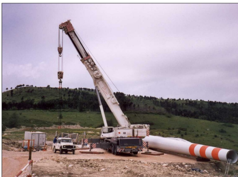
Figura 1.4.6.-1.: Fase di montaggio di un aerogeneratore.
