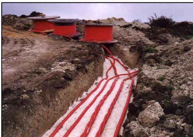
Figura 1.4.7.-1.: Particolare della posa cavi elettrici.
