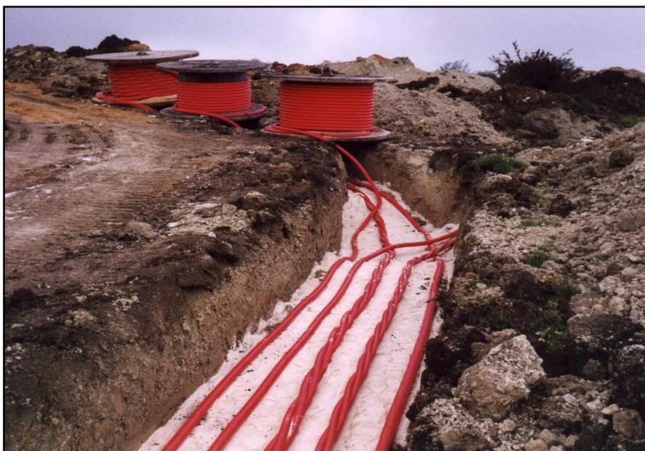
**Figura 1.4.7.-1.: Particolare della posa cavi elettrici.**
