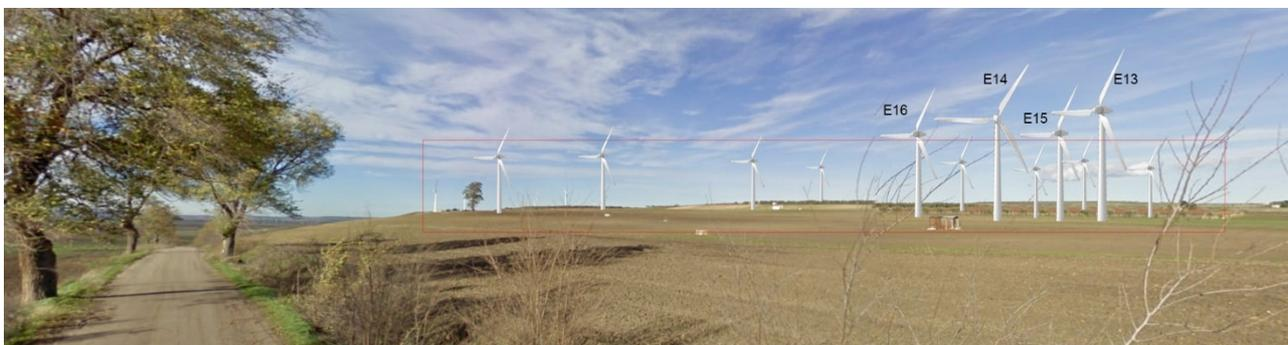
**figura 17:** POST OPERAM\_ La disposizione degli aerogeneratori esistenti e l'elevata interdistanza consentono un inserimento tale da non interferire nella percezione degli elementi caratteristici del paesaggio. Gli impianti maggiormente visibili dal punto di osservazione sono: E13, E14, E15, E16. Il riquadro in rosso identifica l'impianto di progetto.
