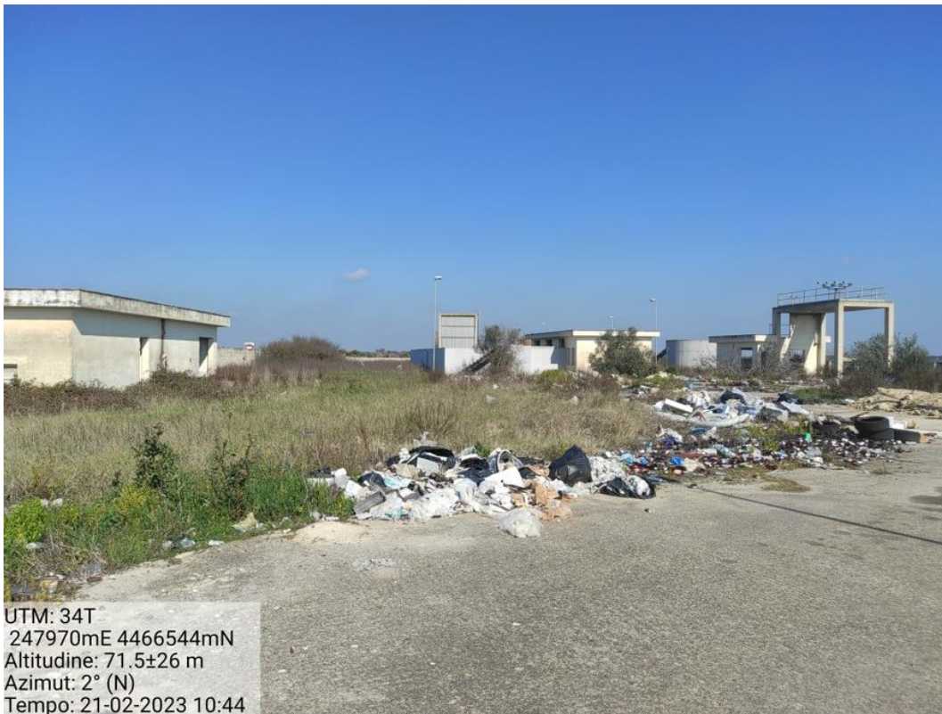
Figura 64 - Impianto dismesso - Foto 46
