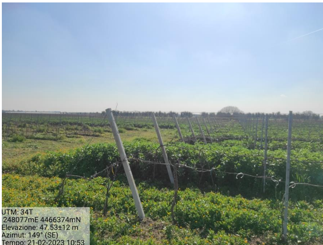
Figura 71 - Vista in direzione Sud-Est in corrispondenza della torre A4 – Foto 57
