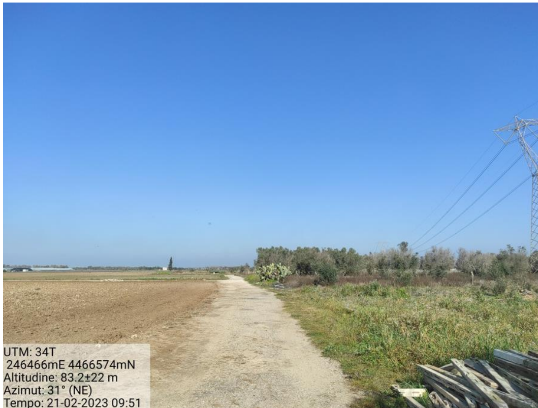
Figura 26 - Linea elettrica AT - Foto 9
