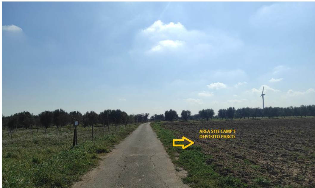
Figura 44 - Area site camp e deposito in fase di cantiere del parco eolico - Foto 93
