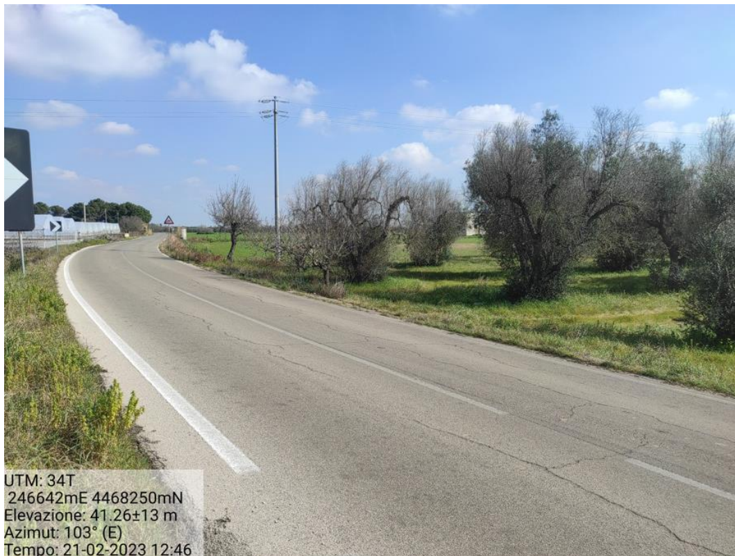
Figura 14 - Interferenza con Linea Elettrica MT-Foto 114
