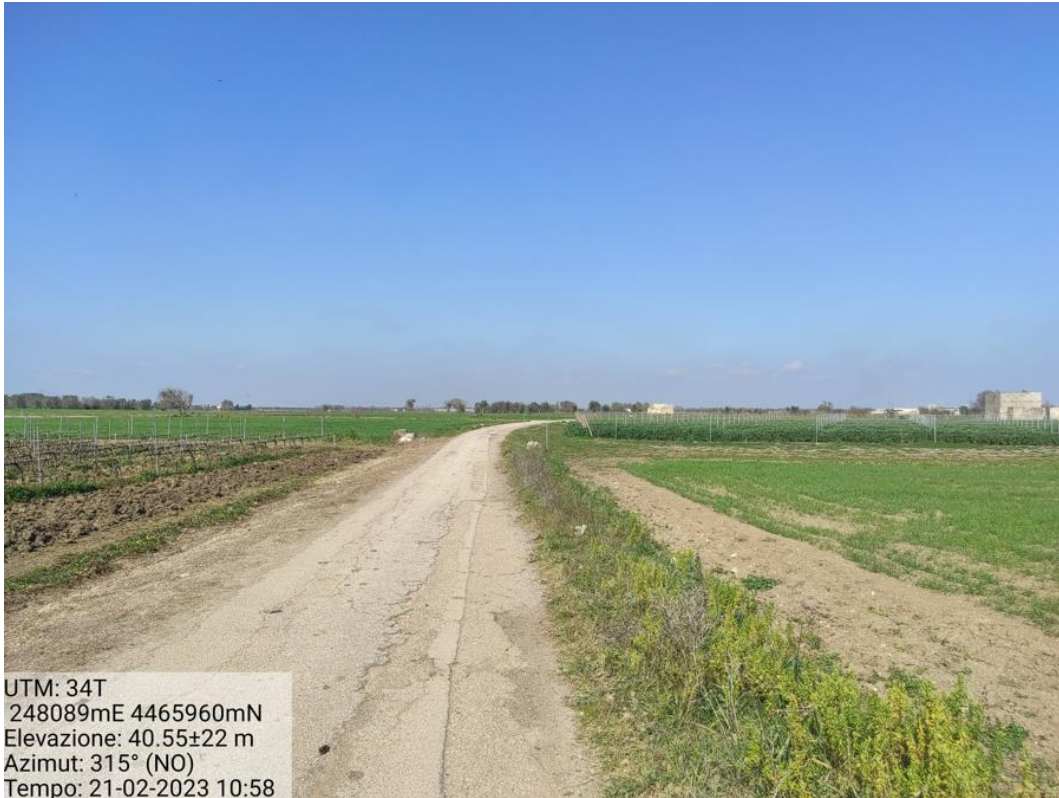
Figura 73 - Vista viabilità esistente da adeguare - Foto 60
