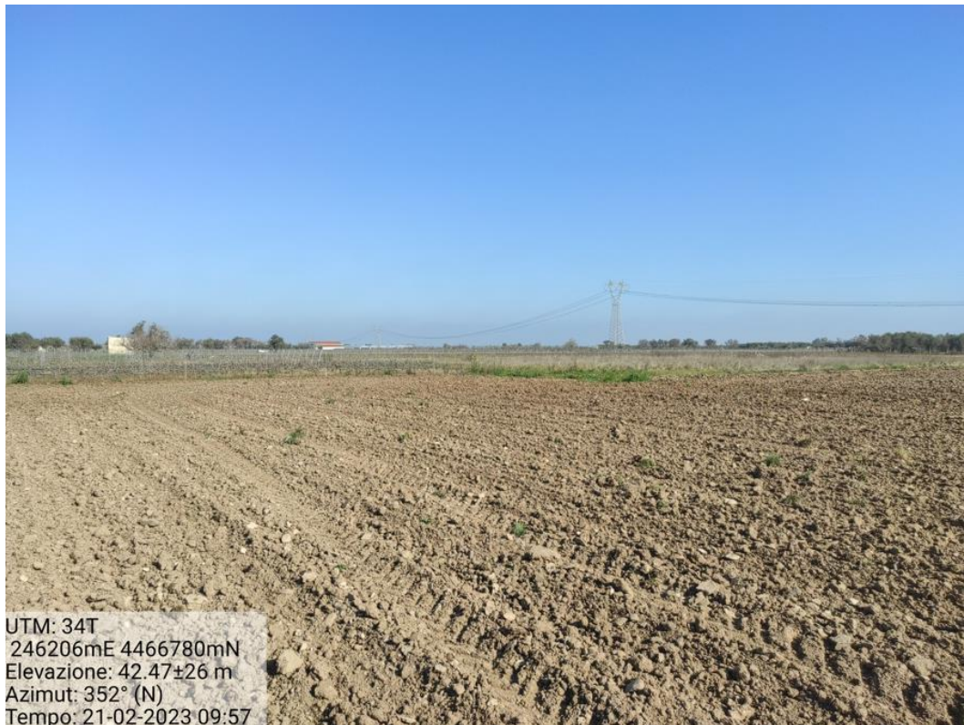
Figura 30 - Vista in direzione Nord in corrispondenza della torre A3 – Foto 16
