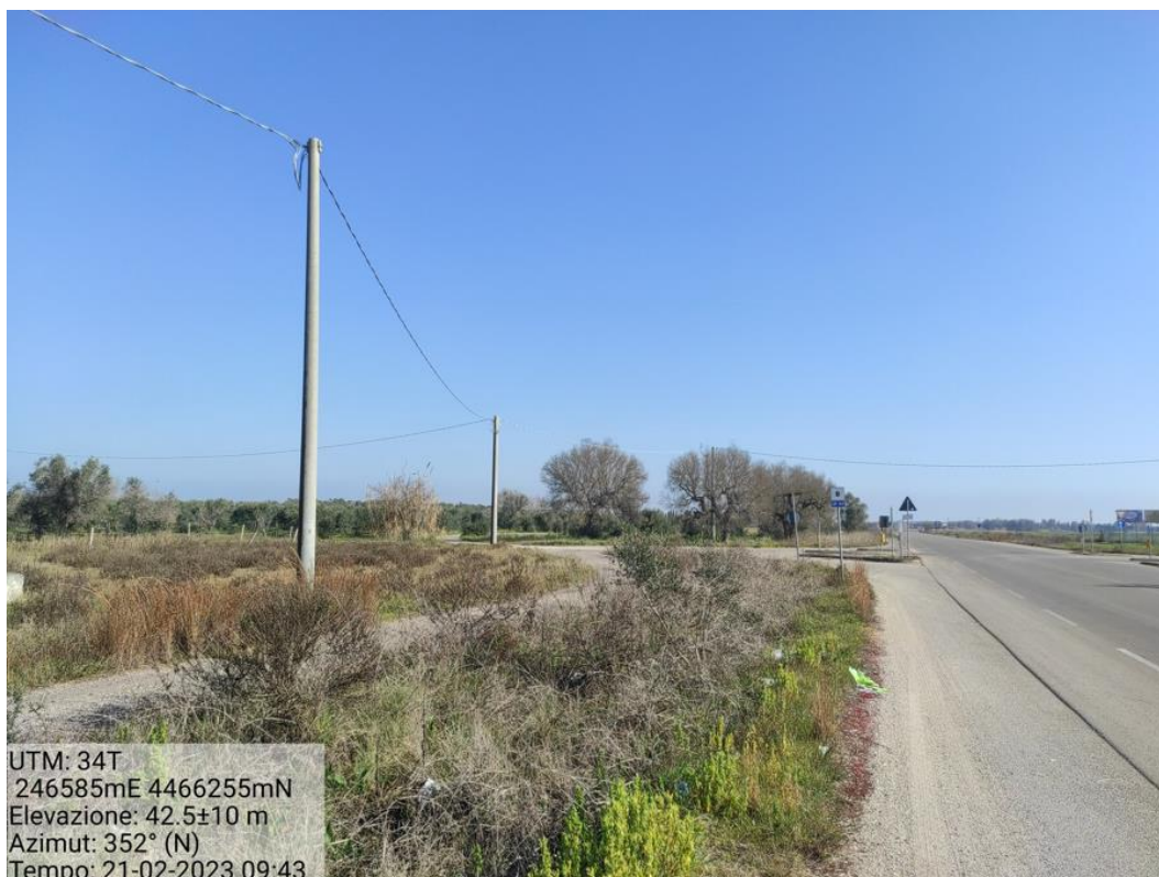
Figura 22 - Linea elettrica BT lungo viabilità di accesso per A3 - Foto 3
