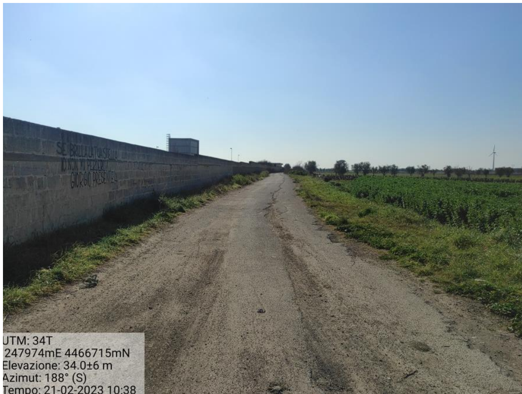
Figura 63 - Viabilità esistente da adeguare verso le torri A4,A6 e A7 - Foto 45
