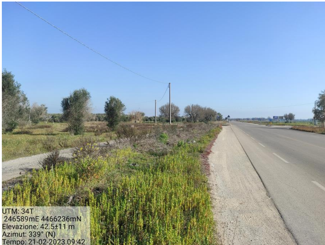
Figura 21 - Curva di accesso alla turbina A3 - Foto 2
