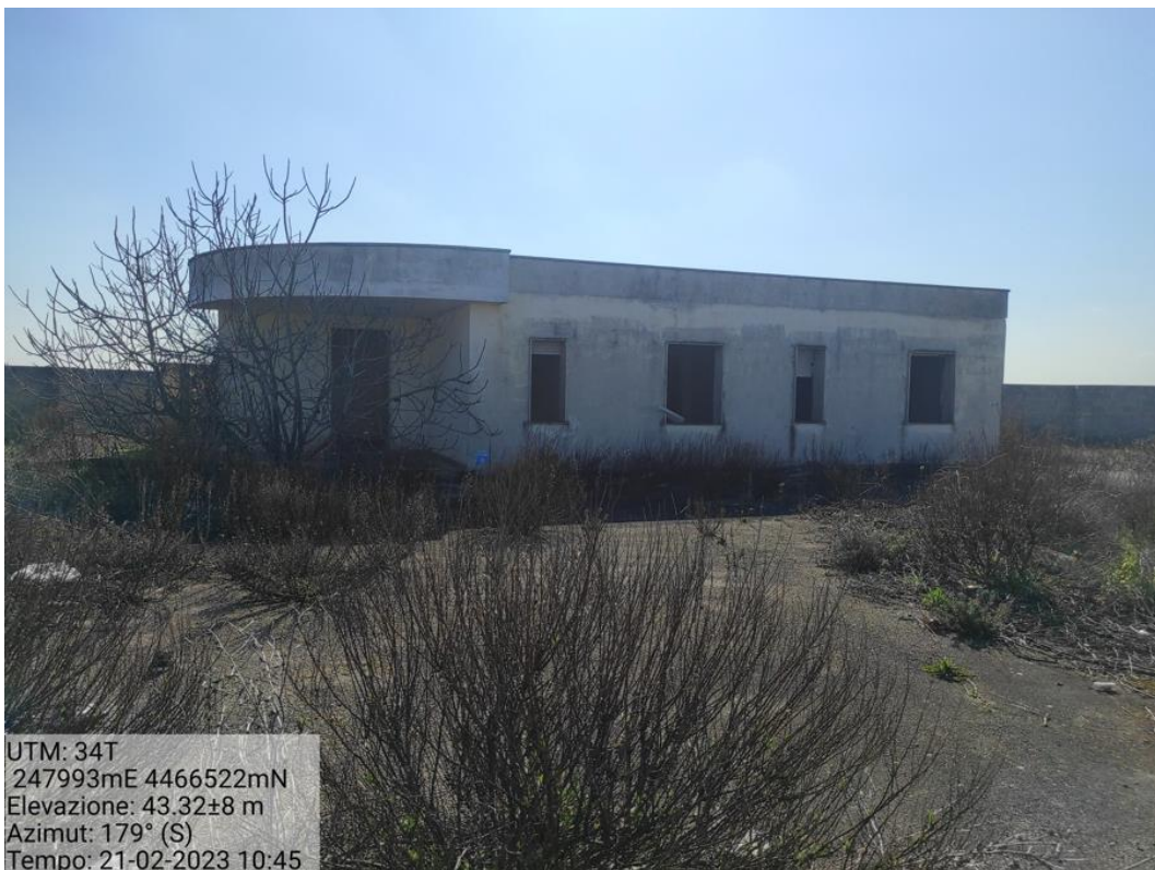
Figura 65 - Fabbricato impianto dismesso - Foto 48
