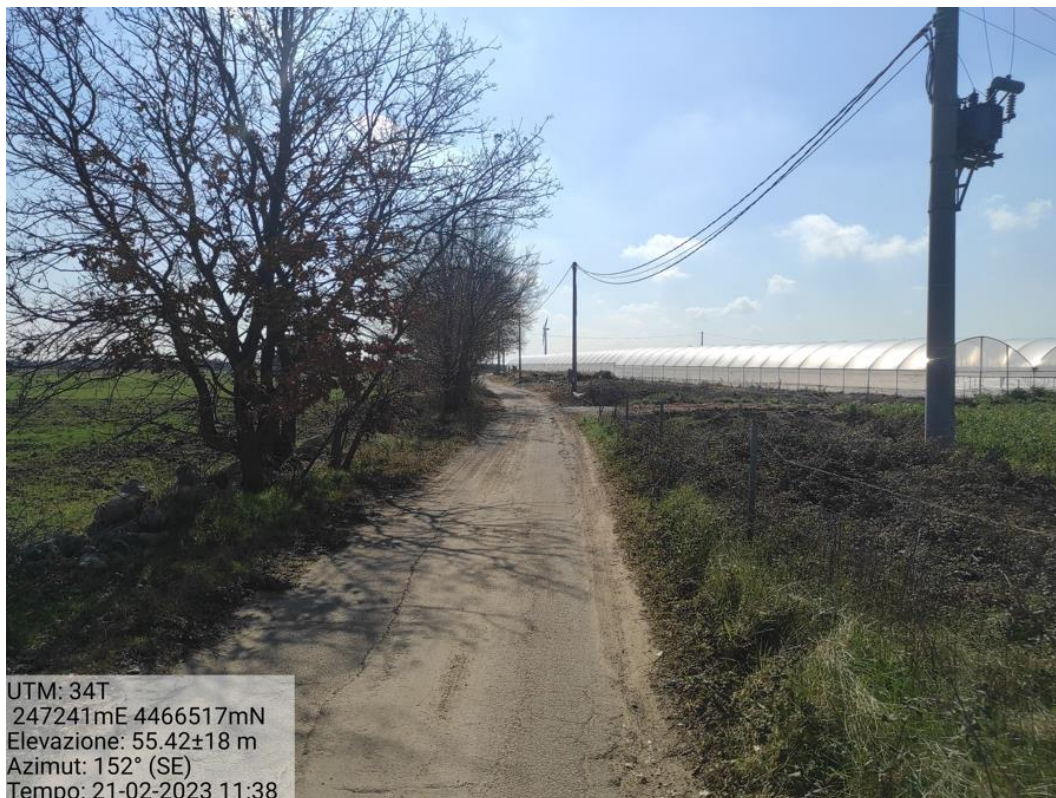
Figura 42 - Interferenza con linea elettrica BT lungo viabilità esistente da adeguare - Foto 89
