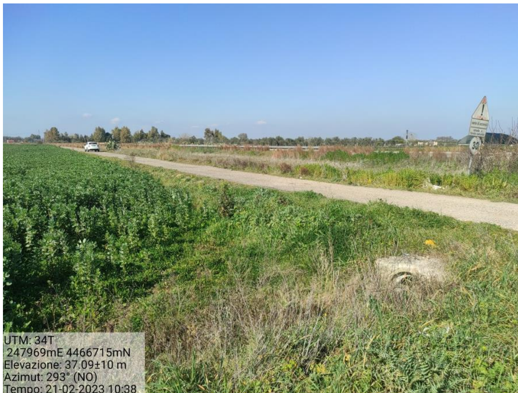
Figura 62 - Rettifica tracciato stradale per accesso alle torri A4,A6 e A7, Fine curva - Foto 44
