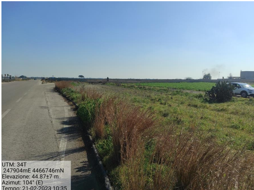
Figura 60 - Rettifica tracciato stradale per accesso alle torri A4,A6 e A7 - Foto 36
