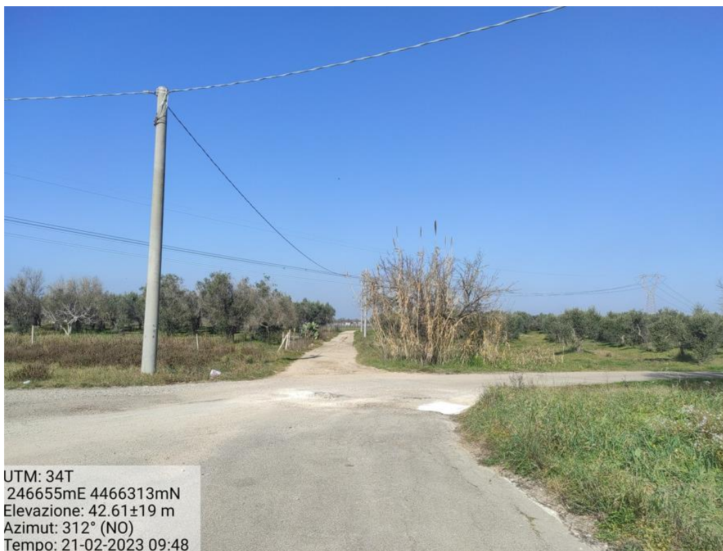
Figura 23 - Linea elettrica BT lungo viabilità di accesso per A3 - Foto 6
