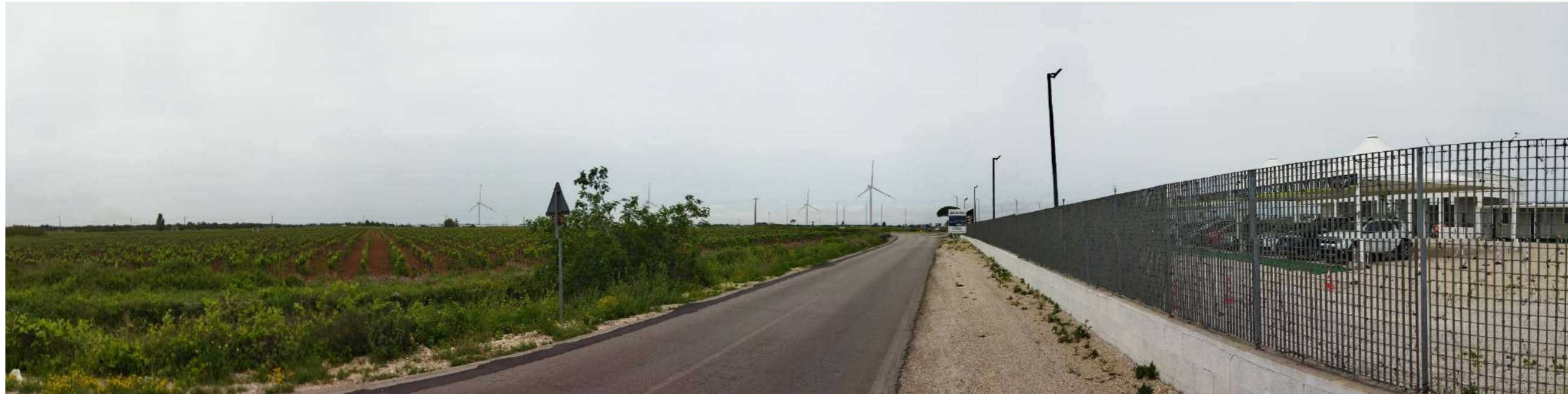
Figura 170: rispettivamente foto (A) dello SDF, foto (B) con indicazioni impianti e foto (C) resa post operam da PV19: "SP119" – Strada a valenza paesaggistica nel PPTR
