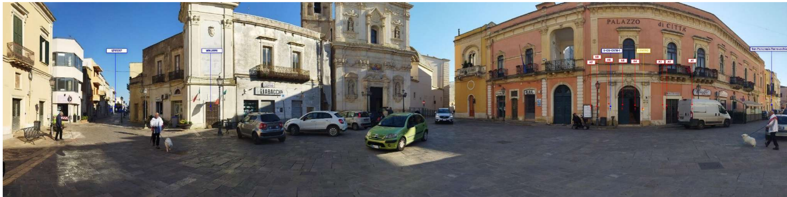
Figura 155: rispettivamente foto (A) dello SDF (coincidente con resa post operam) e foto (B) con indicazioni impianti da PV4: "Chiesa dell'Assunta", nel centro abitato di Monteroni di Lecce
