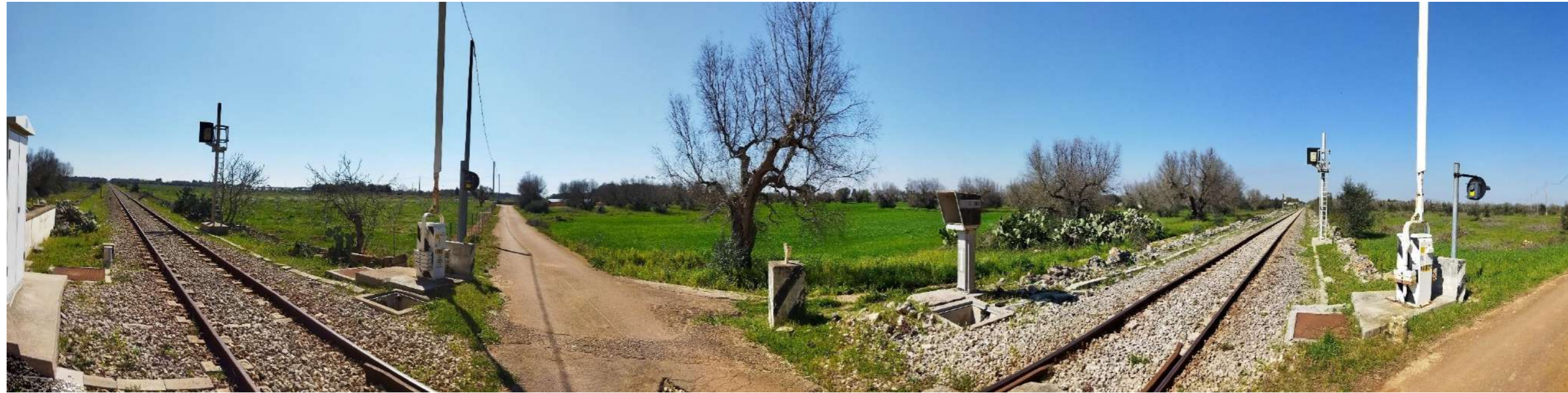
Figura 173: rispettivamente foto (A) dello SDF, foto (B) con indicazioni impianti e foto (C) resa post operam da PV22: "Linea ferroviaria Novoli - Gagliano" – Rete ferroviaria
