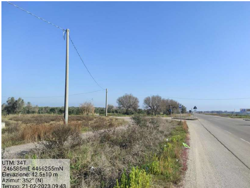
Figura 112: Linea elettrica BT lungo viabilità di accesso per WTG A3 (Foto 3 di Figura 111)
