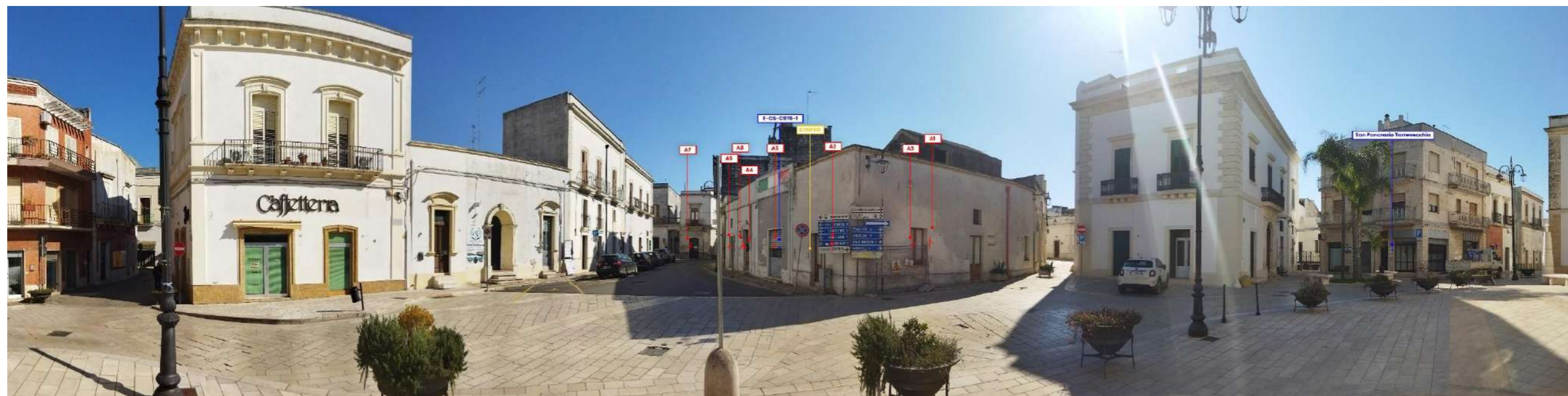
Figura 158: rispettivamente foto (A) dello SDF (coincidente con resa post operam) e foto (B) con indicazioni impianti da PV7: "Piazza Assunta", nel centro abitato di Carmiano
