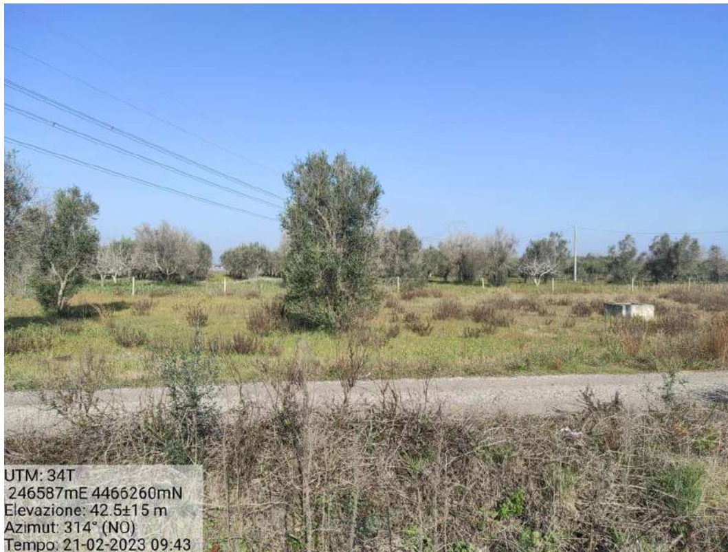
Figura 114: Linea elettrica AT (Foto 4 di Figura 111)
