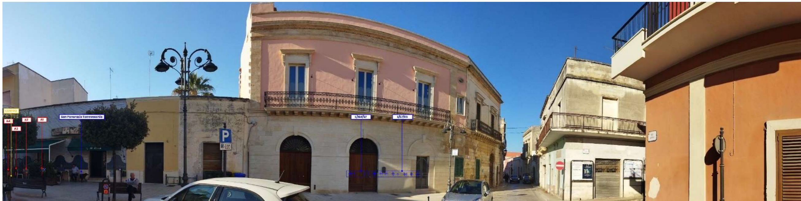
Figura 36: rispettivamente foto (A) dello SDF (coincidente con resa post operam) e foto (B) con indicazioni impianti da PV1: "Piazza del Popolo", nel centro abitato di San Pietro in Lama
