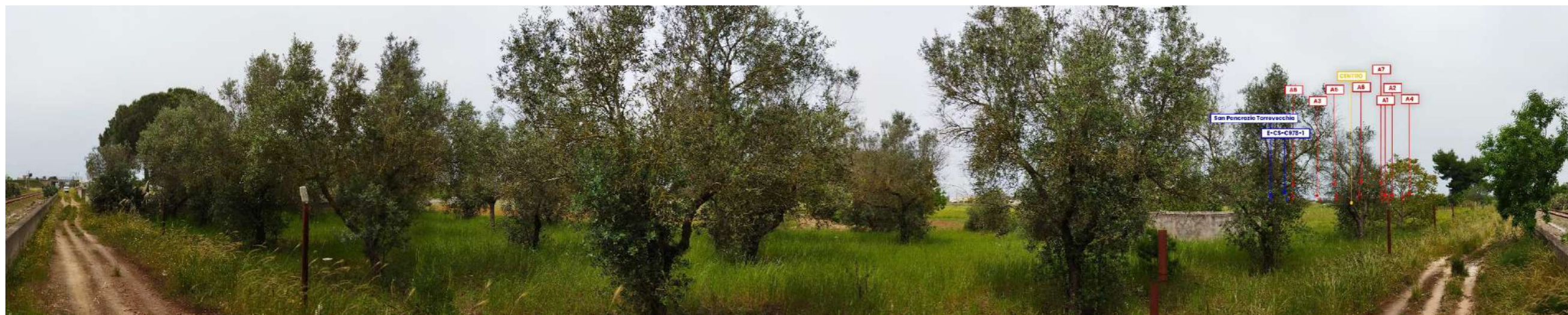
Figura 58: rispettivamente foto (A) dello SDF (coincidente con resa post operam) e foto (B) con indicazioni impianti da PV23: "Linea ferroviaria Novoli - Gagliano" – Rete ferroviaria
