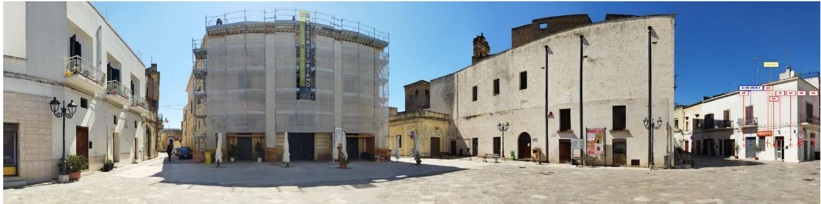
Figura 37: rispettivamente foto (A) dello SDF (coincidente con resa post operam) e foto (B) con indicazioni impianti da PV2: "Piazza del Popolo", nel centro abitato di Copertino
