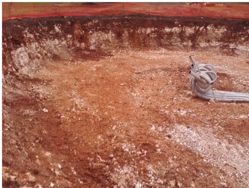
Figura 23: Particolare scavo di sbancamento per fondazioni WTG.
