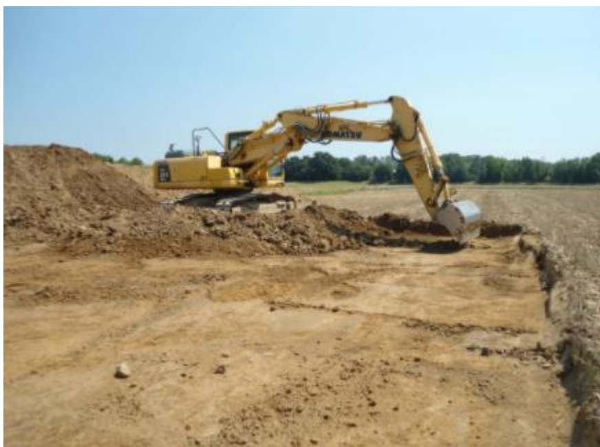
Figura 22: Particolare operazioni di scotico del terreno superficiale.
