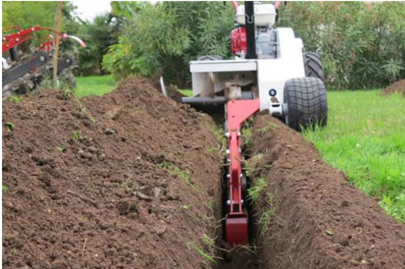
Figura 24: Particolare operazioni di scavo a sezione obbligata.
