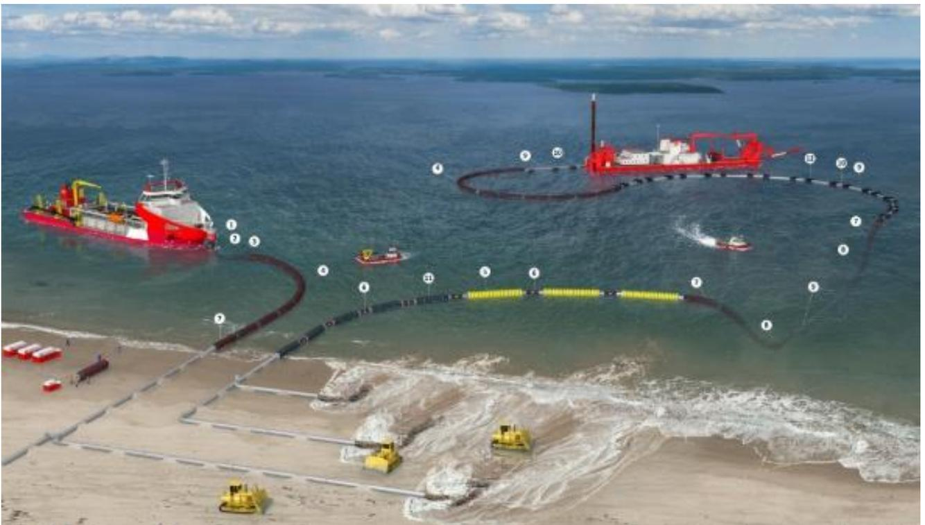
Figura 45 - Operazioni di refluitamento idraulico (Royal IHC, 2018)
