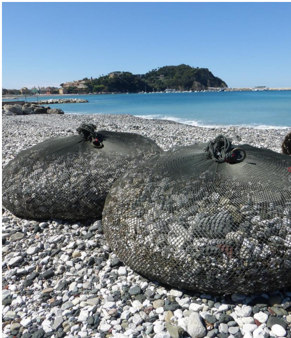
Figura 55: Sacconi zavorrati tipo filter unit in doppia rete di poliestere riempiti di pietrame
