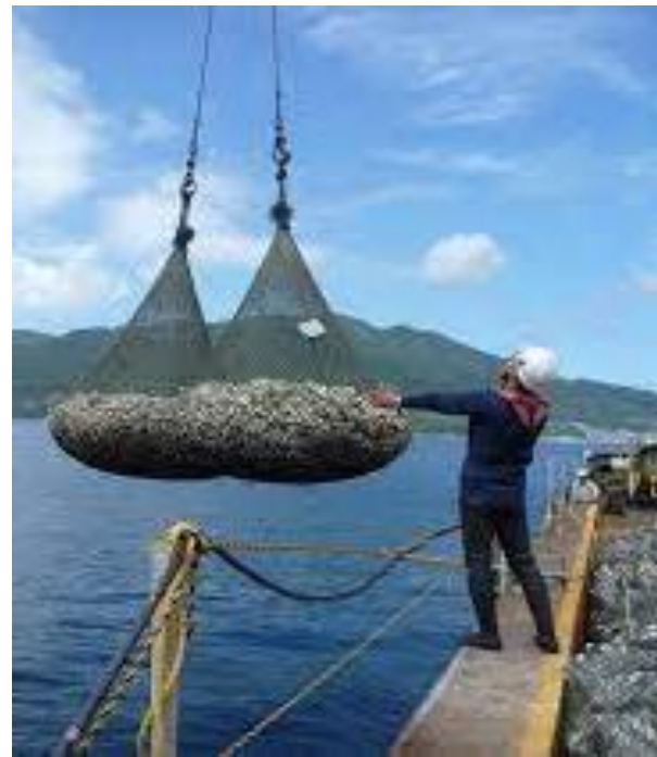
Figura 55: Sacconi zavorrati tipo filter unit in doppia rete di poliestere riempiti di pietrame
