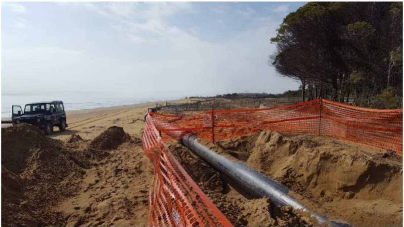
Figura 54: Esempio della posa di un sabbiodotto (Bibione, HS marine, 2019)
